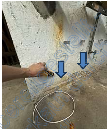
Meßbare und sichtbare Feuchte/Putzschäden KG
