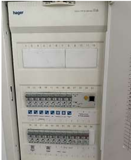
Modernisierte Elektro-Unterverteilung 3.OG
