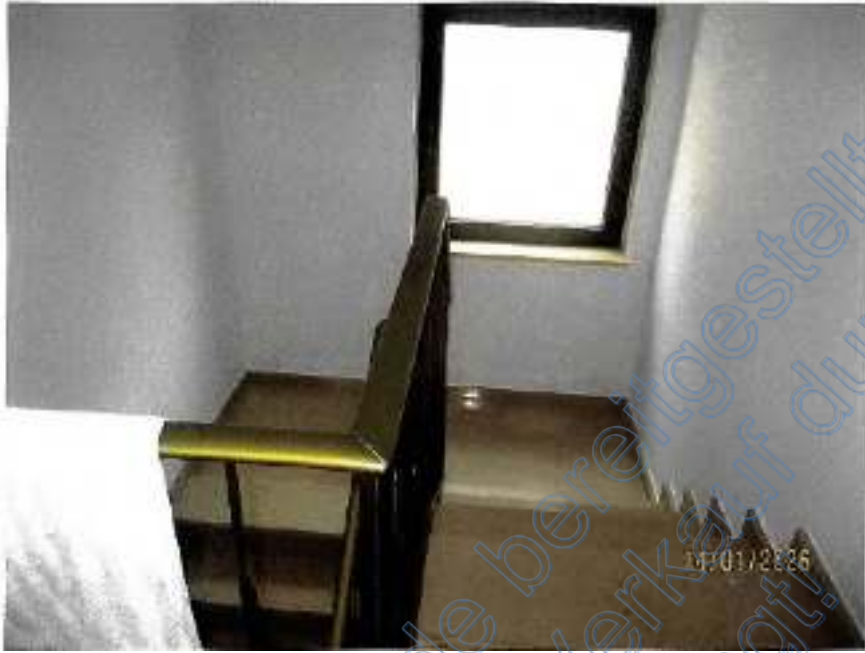
Bild 11: Treppe EG - OG
