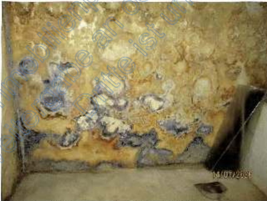
Bild 20: Feuchteschäden KG
