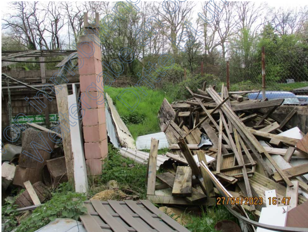
5.8 Grundstück, Rückseite, Bauruinen, belastet mit Sperrmüll, Übersicht
