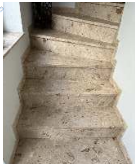
Bild 8: Geschosstreppe vom Wohnungseingangsbereich in die Wohnung im DG
