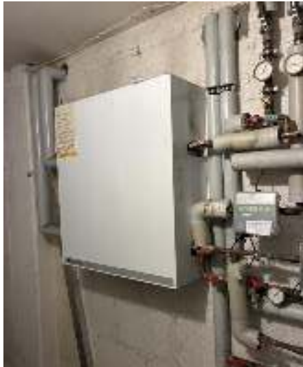
Bild 5: Fernwärmeübergabestation
