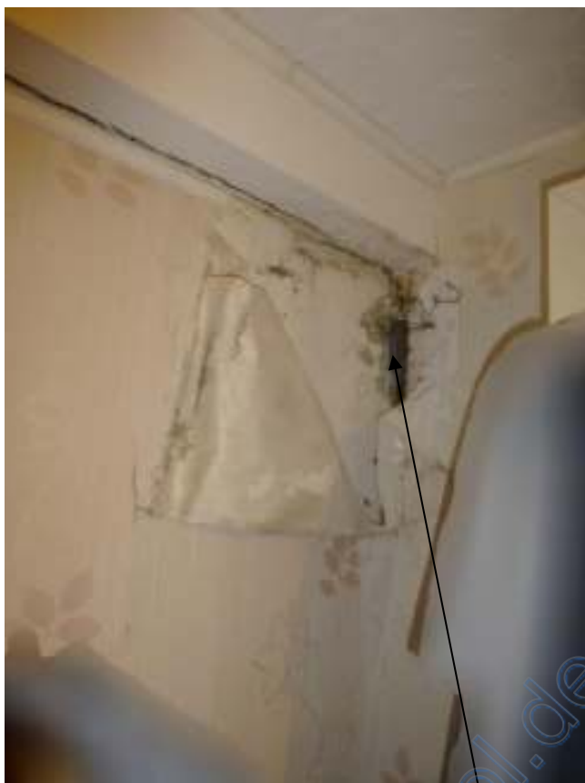
OG – Zwischenraum / Anbau
