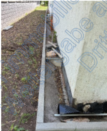
Bild 27: Fehlende Verfüllung Spritzschutzstreifens
