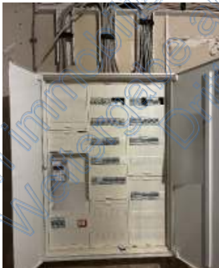
Bild 19: Elektrozählerschrank
