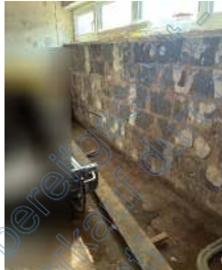
Bild 22: Kelleraußenwand (Feuchteintritt)
