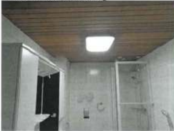
Decke mit Holzverkleidung
