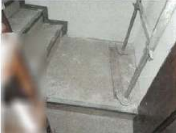
Detail Kunststoff-Treppenbelag
