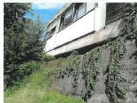
Rückansicht mit Beton-Stützmauer
