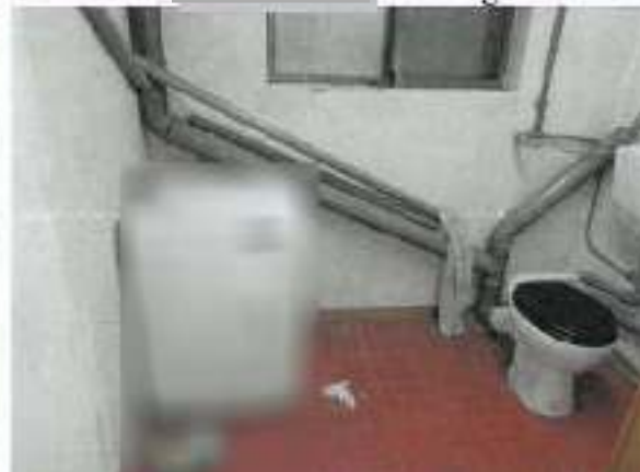
Bodenfliesen; Wandanstrich; Leitungen über Putz
