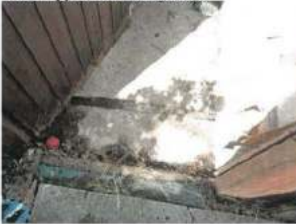
Im Schuppen roher Betonboden
