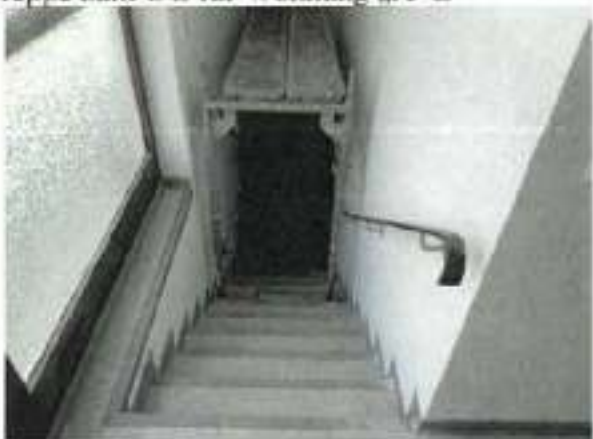
Treppe zum UG für Wohnung „A+B“
