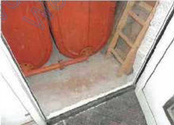
roher Estrich; alte Stahl-Öltanks
