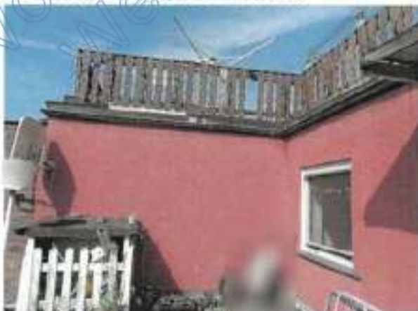
UG-Rückansicht mit EG-Terrasse
