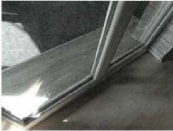
Kunststoffelemente mit Isolierverglasung
