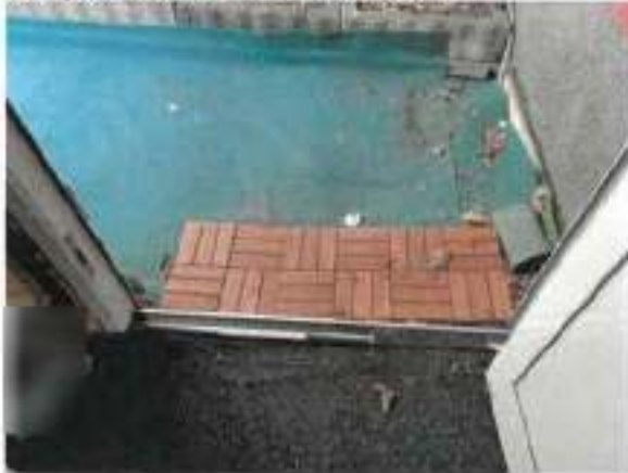
Stolperschwelle im Türbereich
