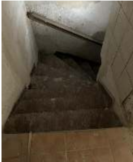
Bild 21: Treppe zum KG
