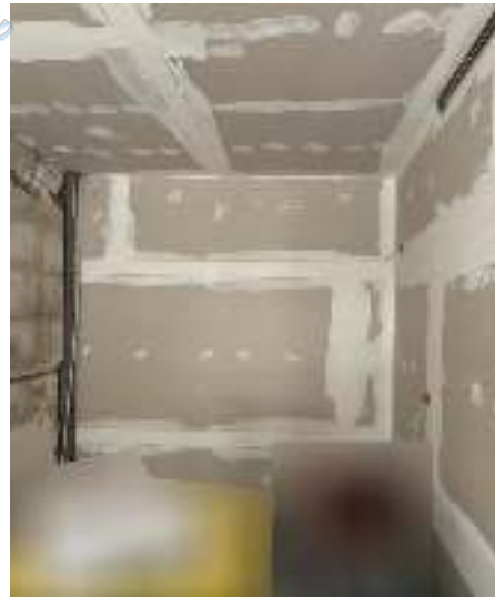
Bild 4: Zimmer EG zur Straße
