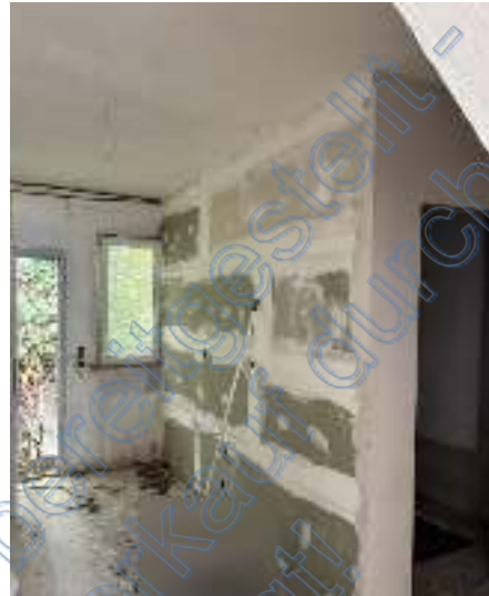
Bild 14: Flur 2. OG, geplanter Sanitärbereich 2. OG
