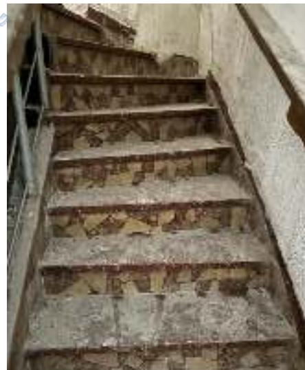
Bild 8: Geschosstreppe zum 1. OG
