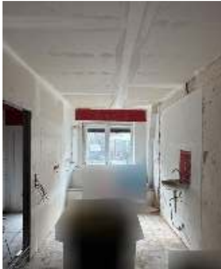
Bild 5: Zimmer EG zur Straße
