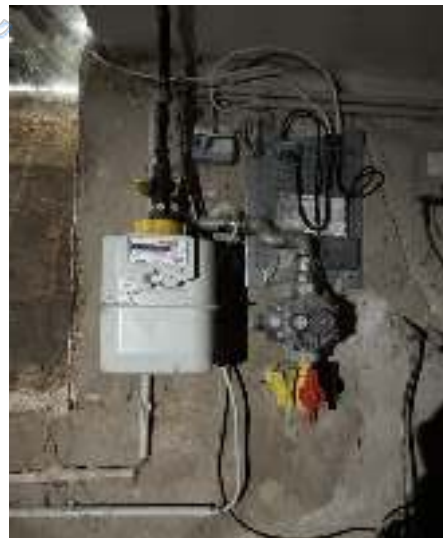
Bild 24: Gaszähler
