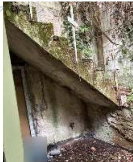
Bild 12: Außentreppe zum 2. OG
