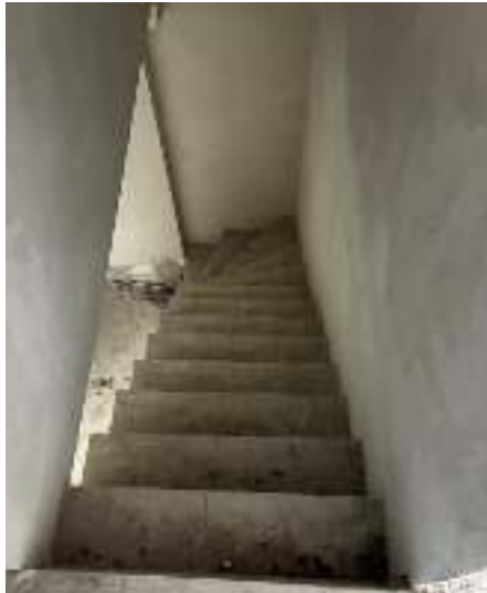
Bild 17: Treppe zum DG
