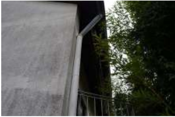
Fassade verfärbt und verschmutzt
