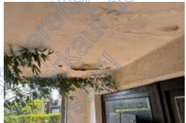
Unterseite Balkon mit Feuchtigkeitsschäden
