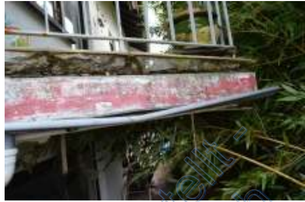
schadhafter Balkonbelag
