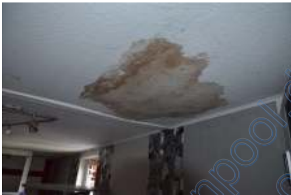
Putz- und Feuchtigkeitsschaden im Hobbyraum exemplarisch
