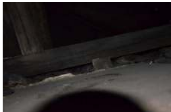
oberste Geschossdecke nicht gedämmt
