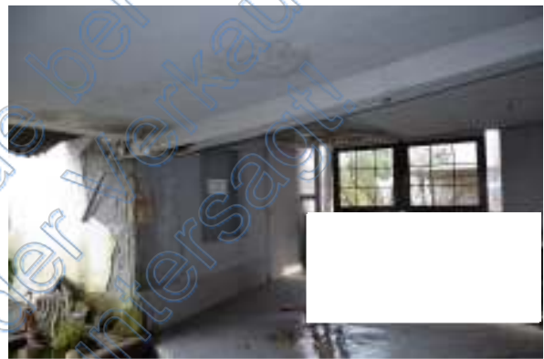
schadhafte Hofüberdachung – provisorisch abgestützt, Zugang zum Schuppen
