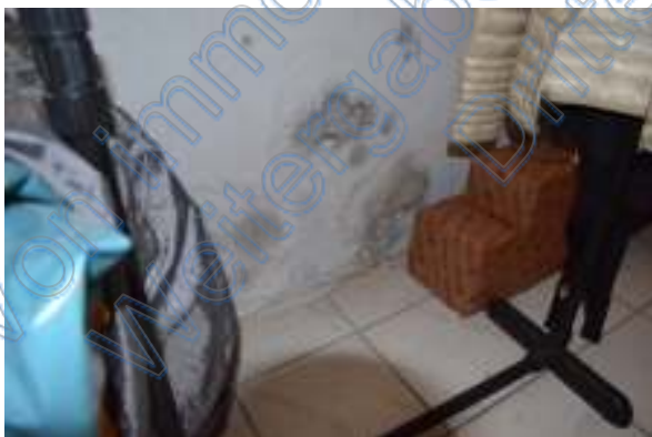
Putz- und Feuchtigkeitsschaden an Kelleraußenwand exemplarisch
