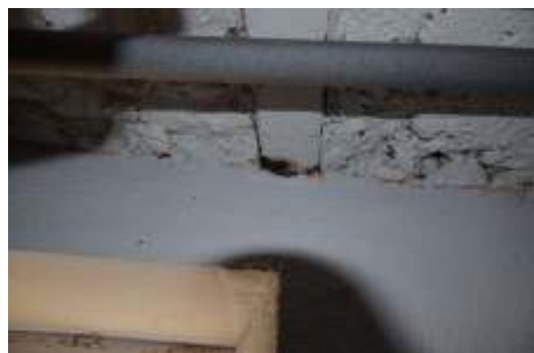
Kellerdecke – korrodierter Stahlträger exemplarisch
