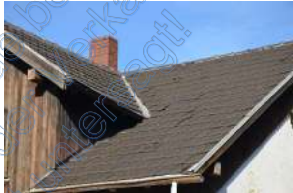
Dachansicht – schadhafte Dachentwässerung exemplarisch
