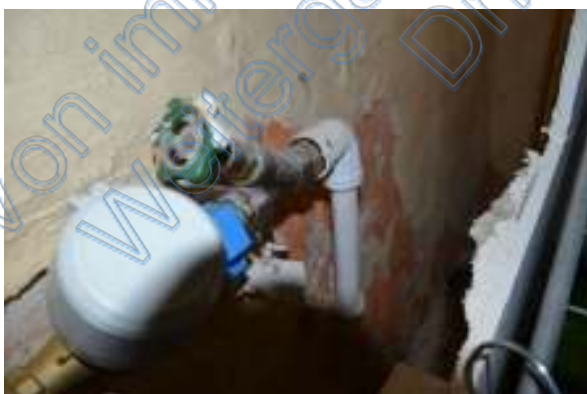
Putz- und Feuchtigkeitsschäden hinter Vorsatzschale im Keller
