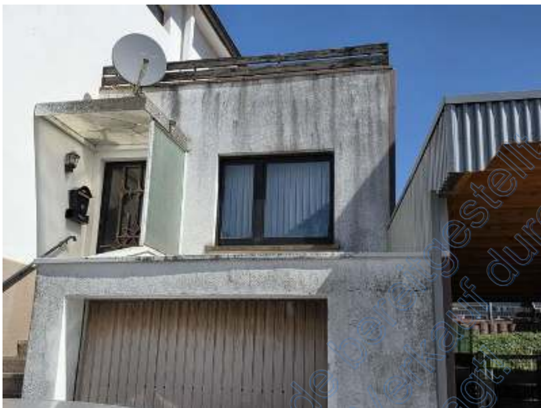
Bild 7 - Anbau/Garage im Haus (2)
