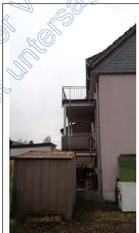
Linke Seitenansicht / Balkon
