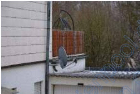
Balkonbrüstung Hauptwohnung und Garagendach rechts
