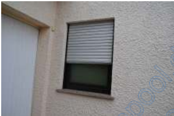
Fassadenansicht mit Putz exemplarisch
