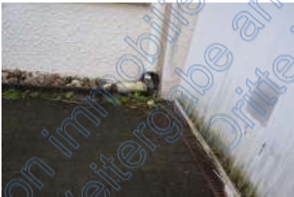
schadhafte Dachentwässerung
