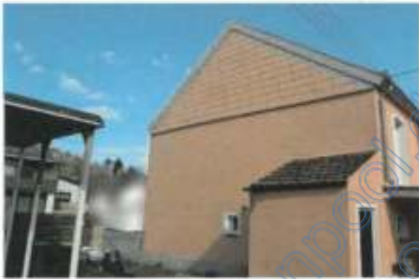
Giebelansicht rechts mit Geräteraum
