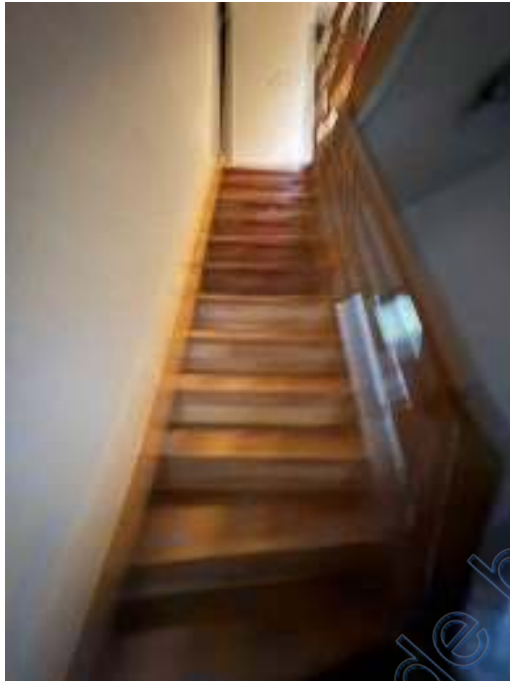
Treppe EG zu OG (links)
