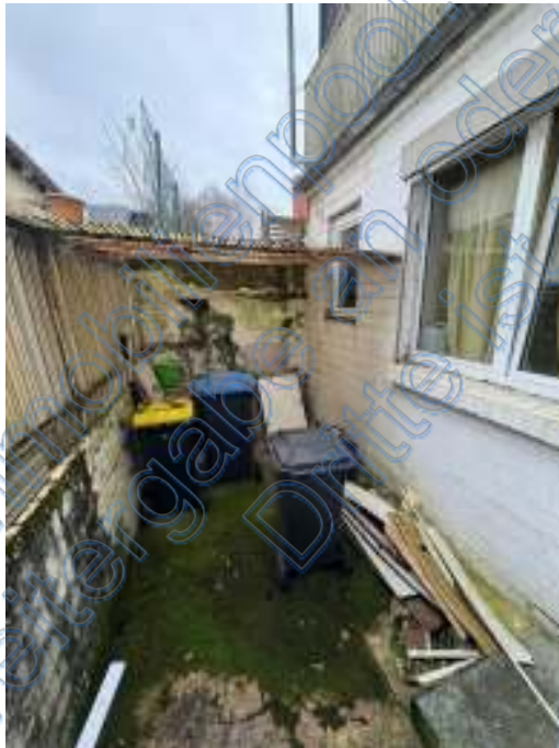
Fassade Anbau (rechts)
