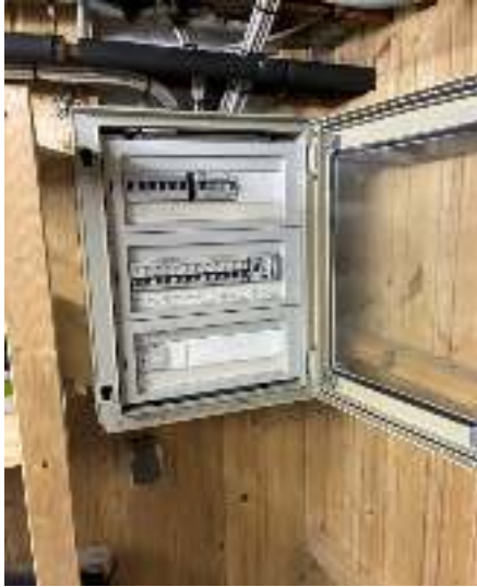
Bild 13: Elektrounterverteilung
