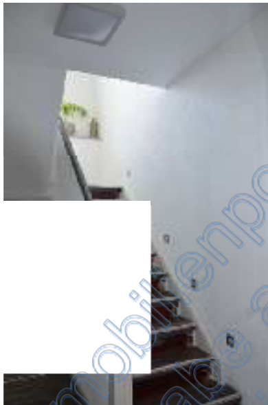
Treppe – Setzstufen nicht fertiggestellt
