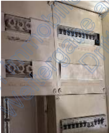
Bild 7: Zählerschrank
