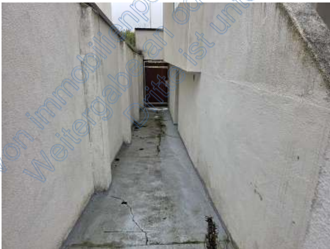
Bild 4 - Durchgang neben dem Haus
