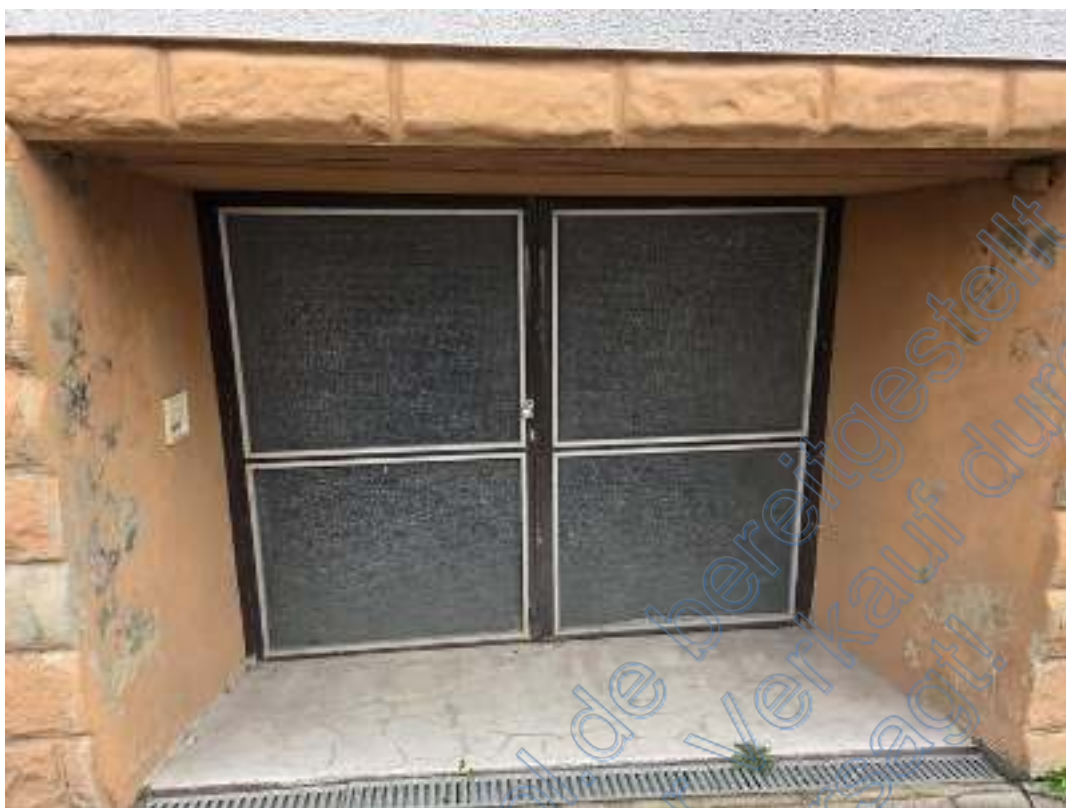
Bild 7 - Zugang Keller (ehem. Garage)
