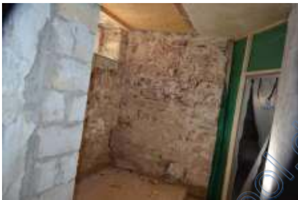
Treppenraum im KG
