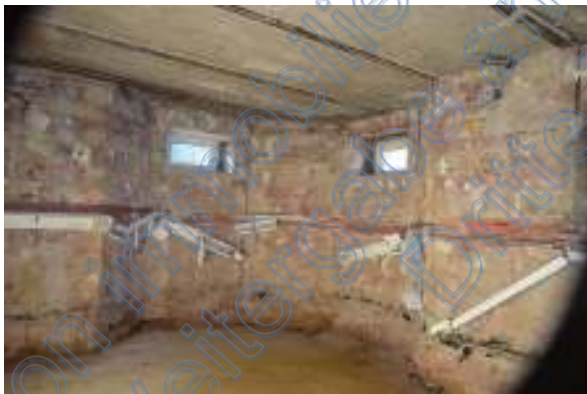
Wände ohne Putz, Böden ohne Estrich
