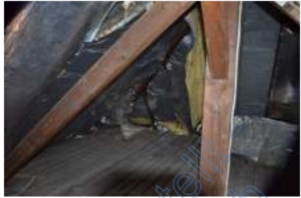
Speicher mit gedämmten Dachflächen
