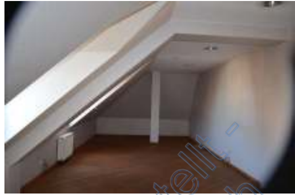
Raum DG exemplarisch
