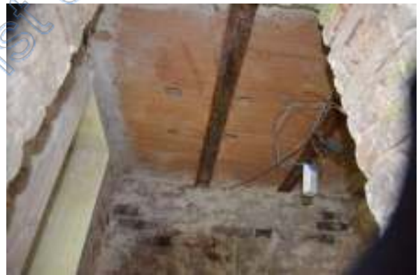
Decke Abstellraum (Teeküche) im Rohbauzustand
