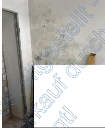
Bild 10: Feuchte- und Putzschäden EG Giebelwand
