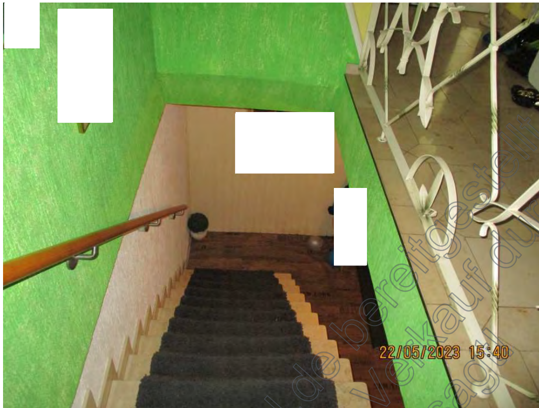
5.11 Diele, Keller-Innentreppe, Übersicht
