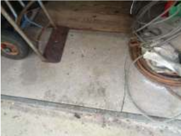
roher Estrichboden; lokal schadhaft
