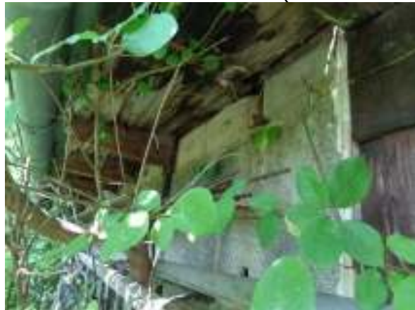
teils rohes Außenmauerwerk (fehlender Putz)
