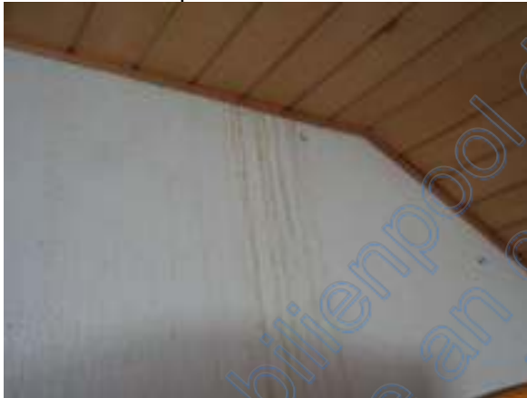
Wasserablaufspuren unter Kehl balkendecke
