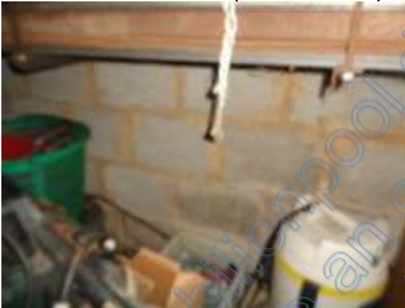
Innen rohes Mauerwerk (fehlender Putz)
