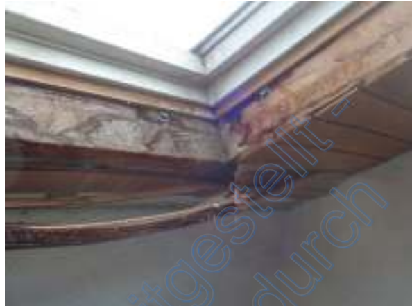
undichtes Holz-Dachflächenfenster
