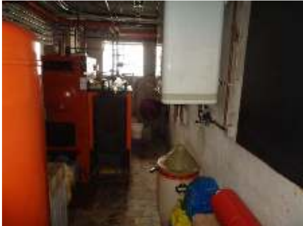
Heizraum mit Elektro-Warmwasserboiler
