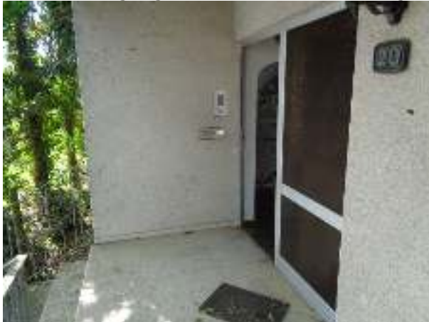
Alu-Hauseingangselement mit Einfachverglasung vorderseitige EG-Terrasse
