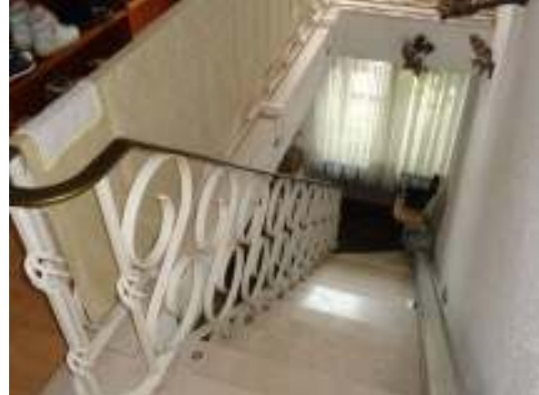
Treppe EG-DG mit Werksteinstufen
