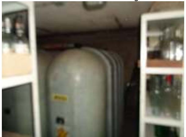
Kunststoff-Batterietanks im Öllageraum
