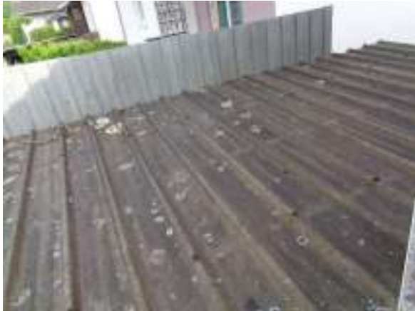
Hofüberdachung aus Kunststoff-Platten
