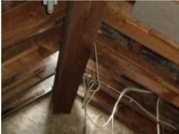
Lokale Dachundichtigkeit; fehlende Firstziegel
