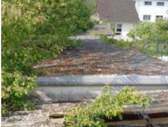
Eternitdeckung Garage vermutlich asbesthaltig rückseitiger Garten verwildert
