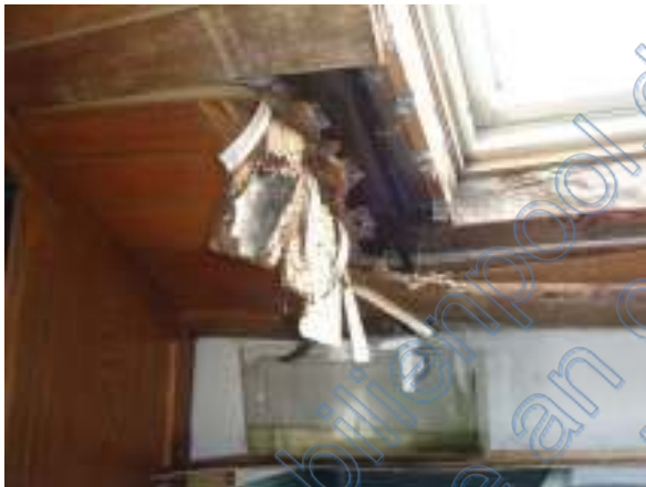
Feuchteschäden Bereich Dachfenster
