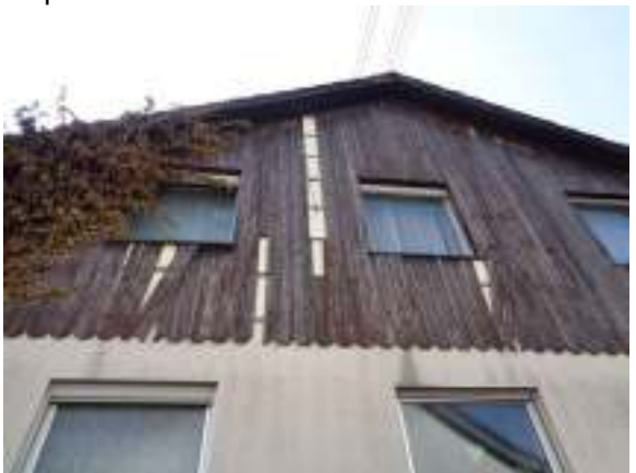
Beispiel schadhafte Holz-Fassadenverkleidung
