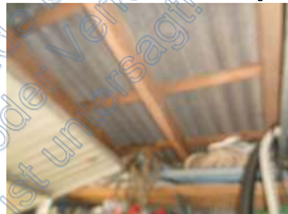
Dachuntersicht mit Welleternitdeckung
