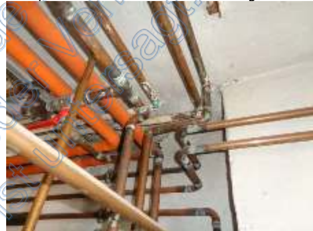
Beispiel Korrosionsschäden Heizungsrohre
