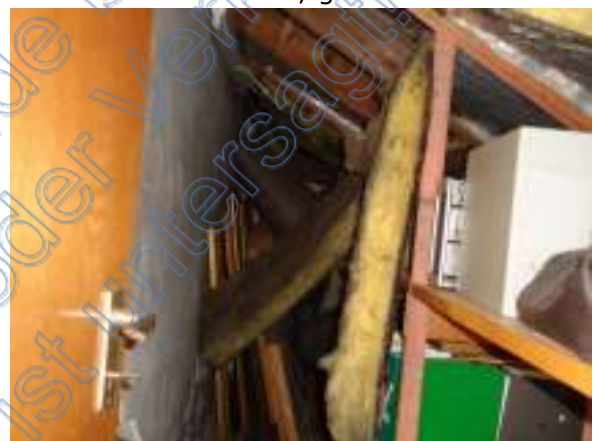
Kniestock-Abstellraum; gelöste Dachdämmung
