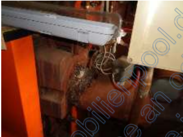
Schadhafter Festbrennstoff-Kessel
