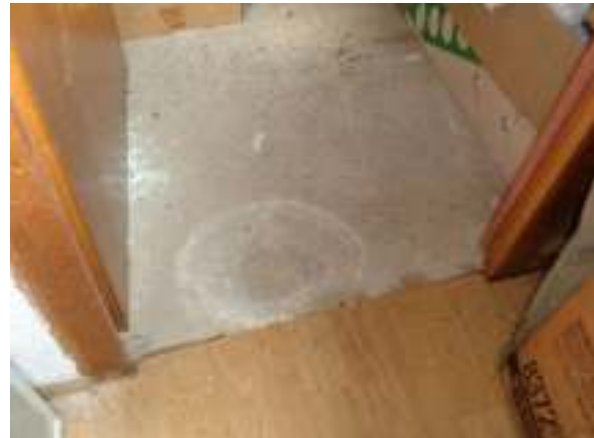
Detail roher Estrichboden Abstellraum
