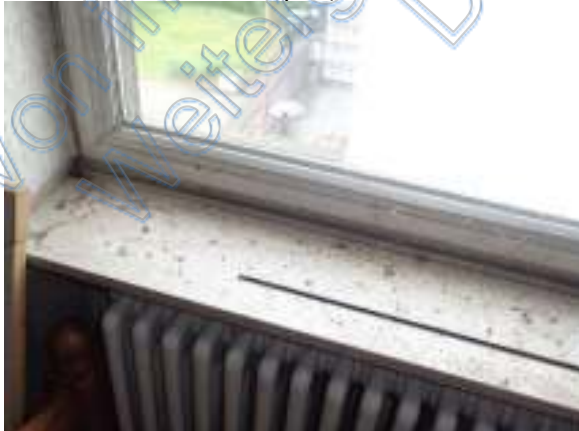
Detail Gliederheizkörper; Werksteinfensterbank Holz-Werkstofftüren
