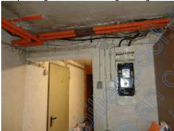
Beispiel ungedämmte Heizungsleitungen
