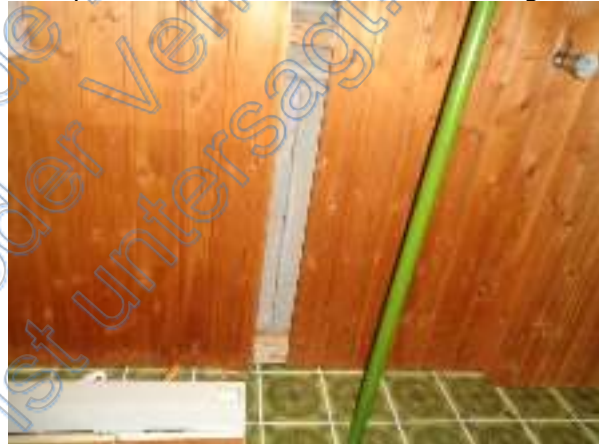
Beispiel schadhafte Deckenverkleidung
