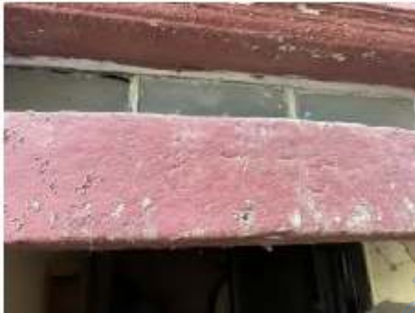
Türsturz über Eingang
