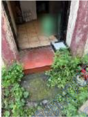
Raum EG Nord (rechts)
