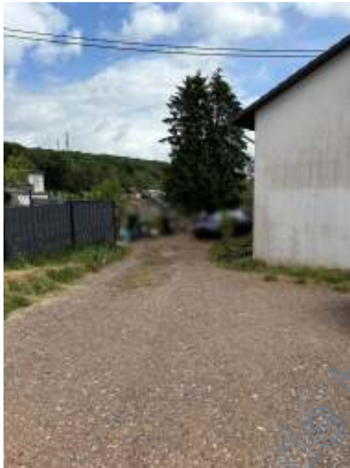
Haus- fassade West (rechts)
