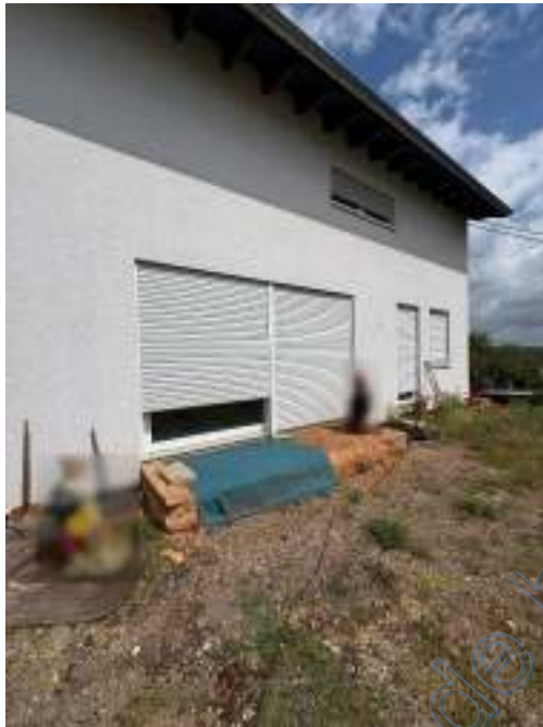
Hebean- lage in Außen- anlage (rechts)
