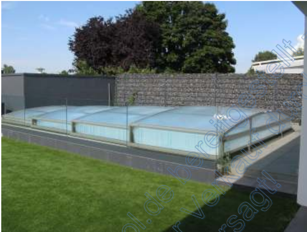
Außenpool und Rückseite Garage (fehlende Baugenehmigungen)
