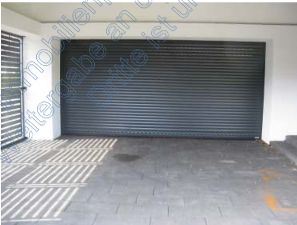
Doppelgarage mit überdachter Zufahrt (fehlende Baugenehmigung)
