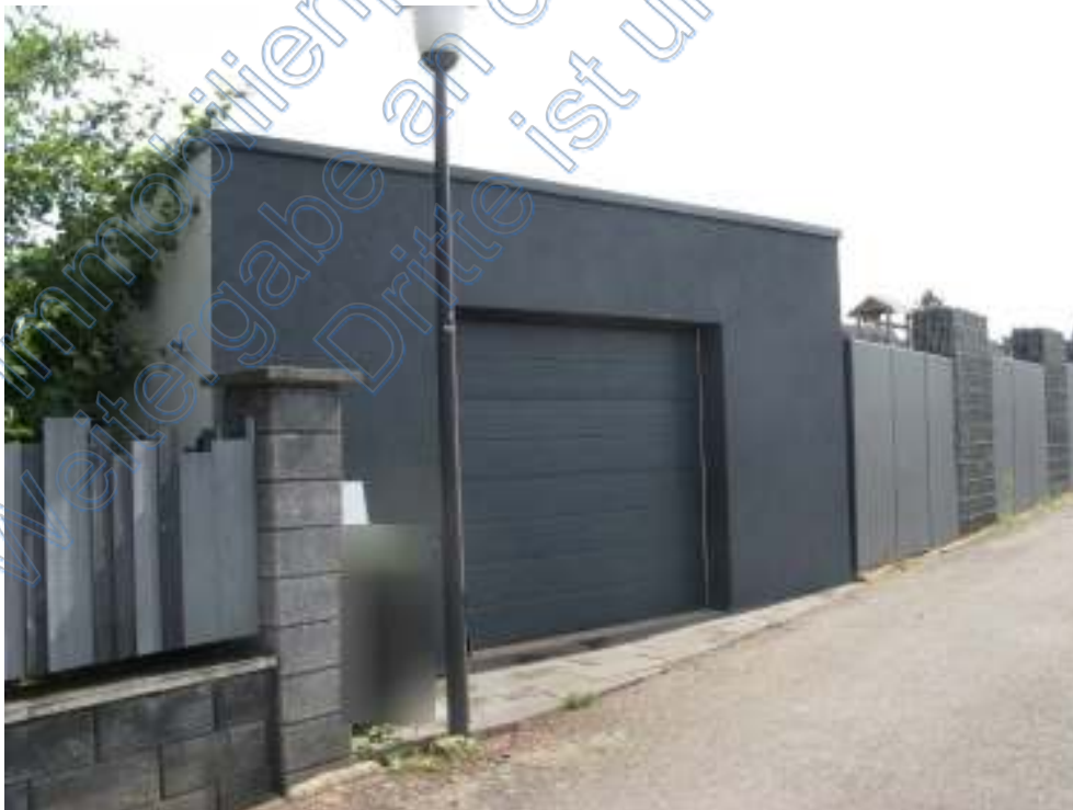
Garage Grundstücksrückseite (eingeschränkte Zufahrt, fehlende Baugenehmigung)
