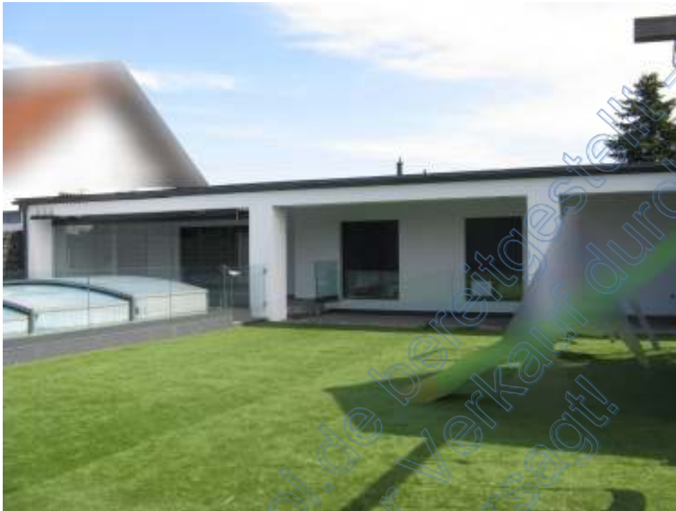
Gartenansicht (Terrassenüberdachung, fehlende Baugenehmigung)
