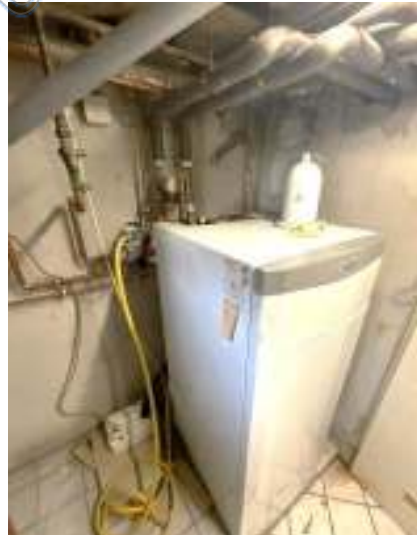
Gasbrennwertheizung Bj. 2015
