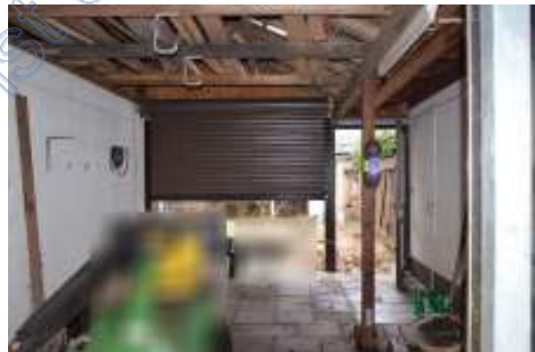
überdachter Unterstand zwischen den Garagen
