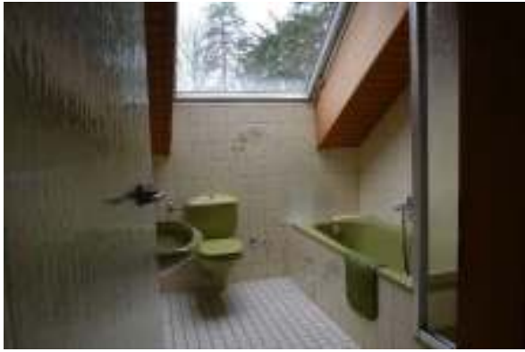
Bad im DG
