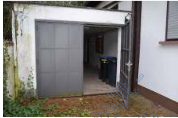
Garage am Wohnhaus
