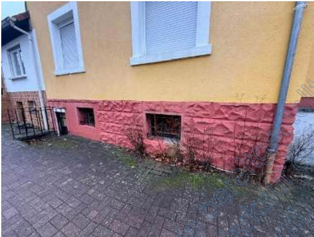
Oberbexbacher Straße – Kellergeschoss unter dem Hauptgebäude
