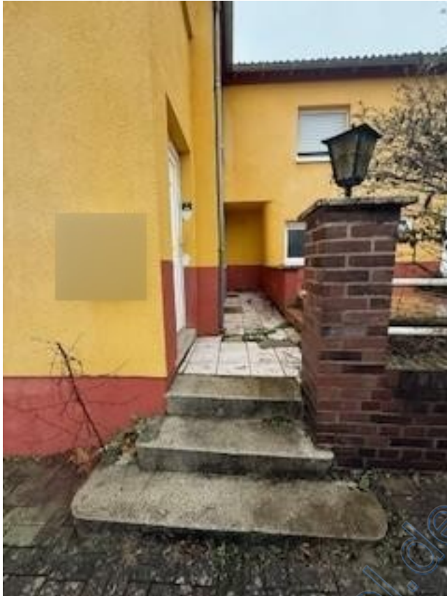
Beethovenplatz, Zugang zum Gebäude
