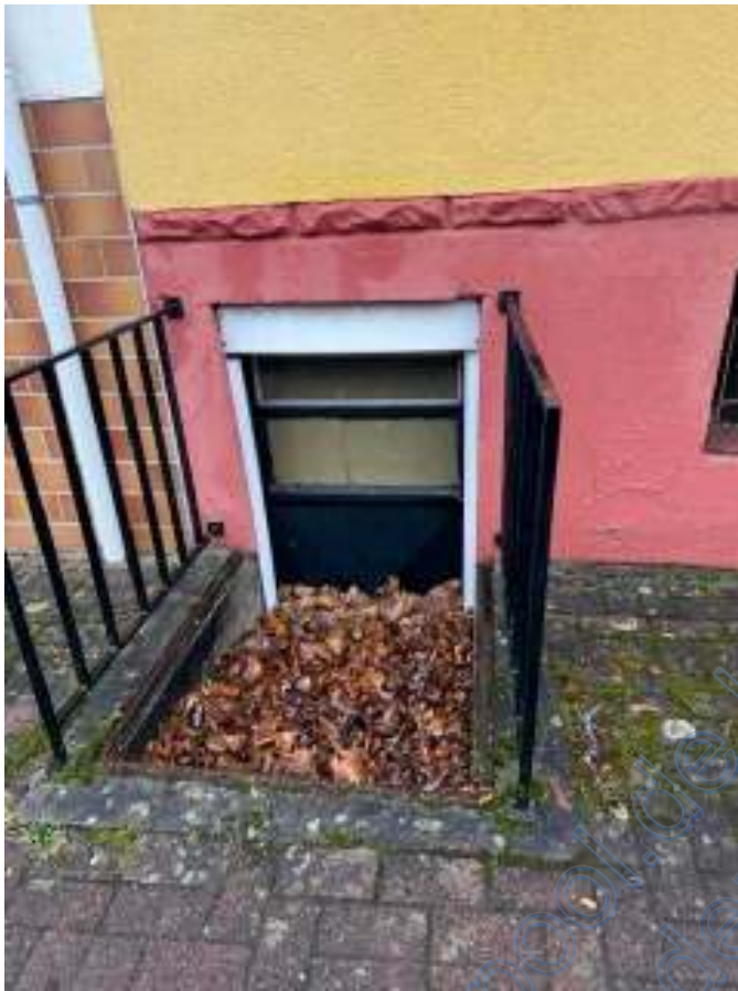
Oberbexbacher Straße – Zugang zum Kellergeschoss unter dem Hauptgebäude
