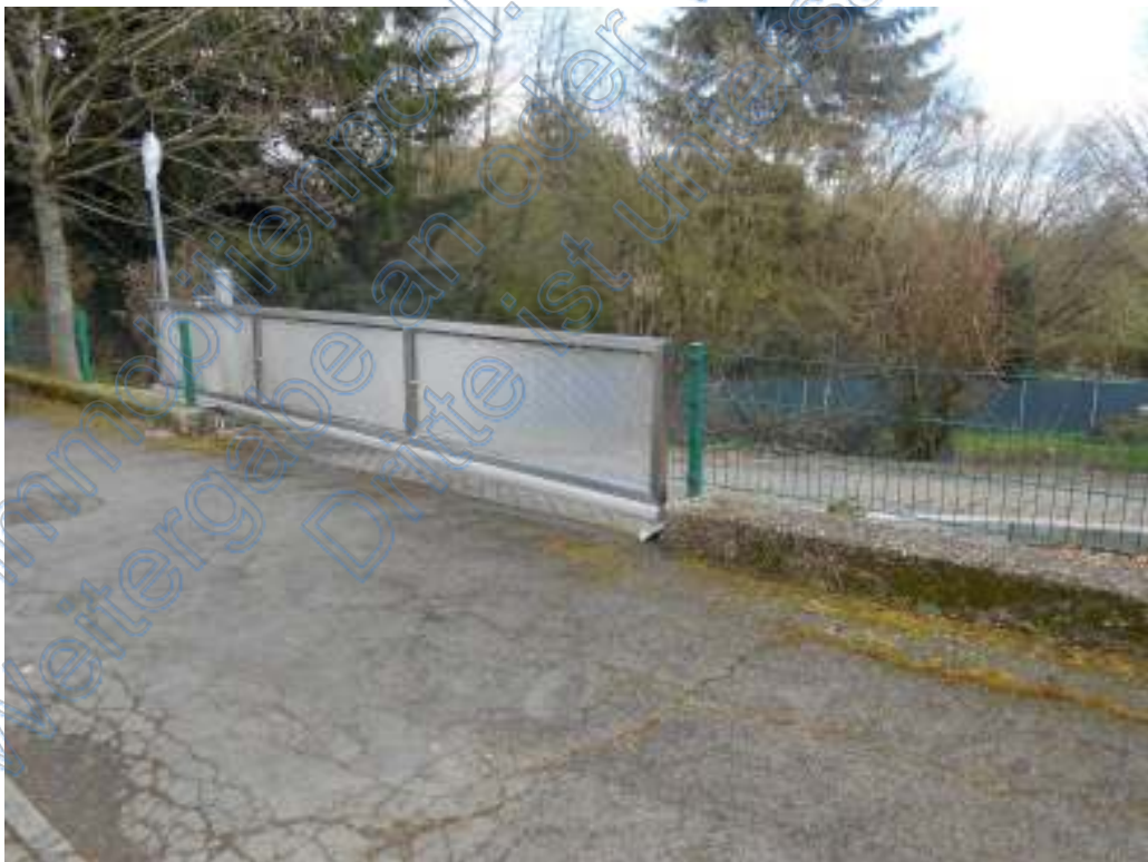
Einfriedung mit Toranlage (Flurstück 1077/2)
