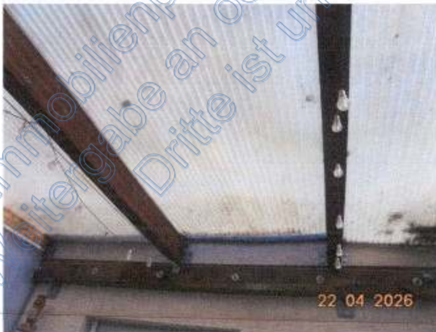
Überdachung Balkon zur Straße
