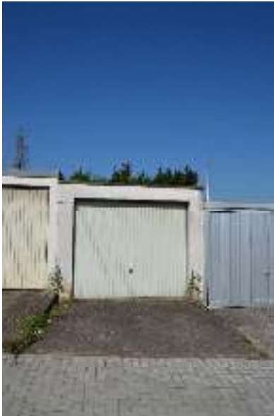
Straßenansicht, Fassade und Tor verfärbt und verschmutzt
