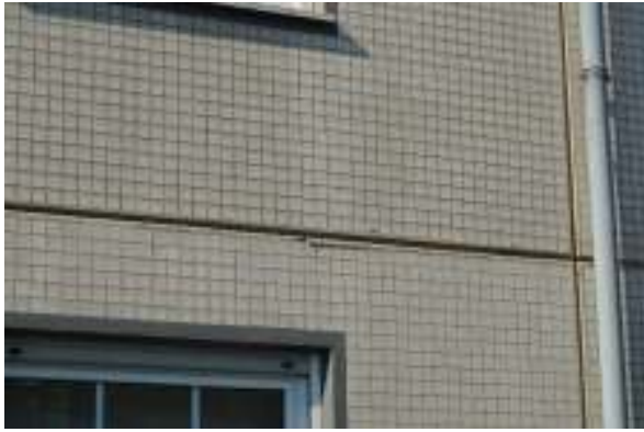
schadhafte Dehnungsfuge
