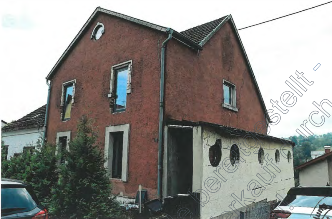
Rechte Seitenansicht, Dämmung am Treppenaus ist verwittert und unbrauchbar
