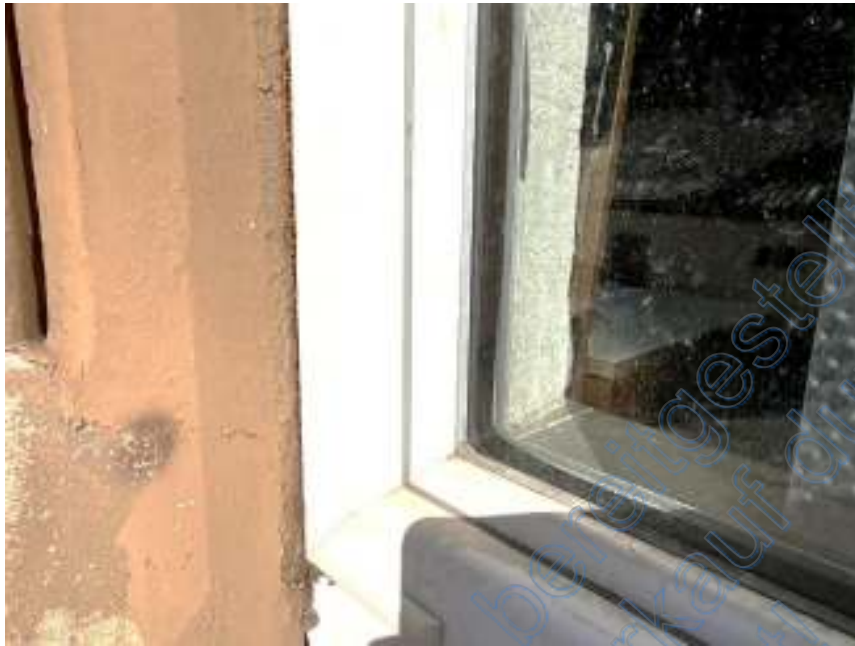
Detail älter modernisierte Fenster EG Süd
