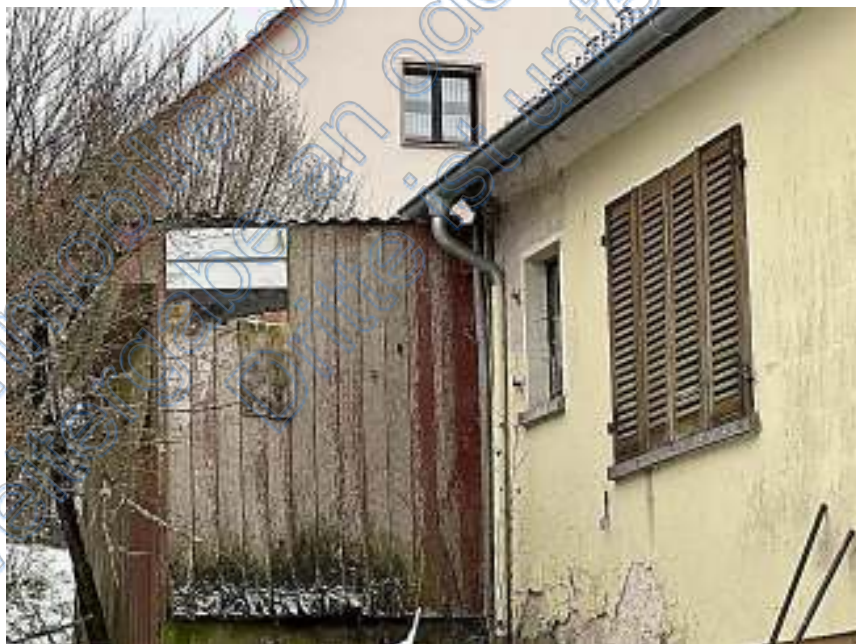
Schuppen-Anbau an Windfang Ost
