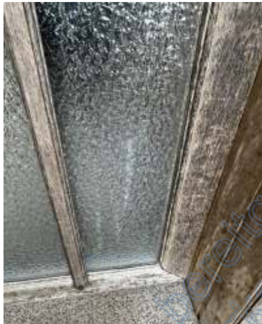
Einfachverglaste Eingangstür, Modernisierung aller Fenster/Türen/Rolläden unterstellt
