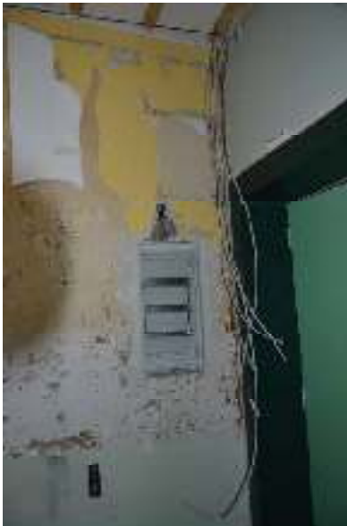
Verteilerschrank – Elektroinstallation nicht fertiggestellt exemplarisch
