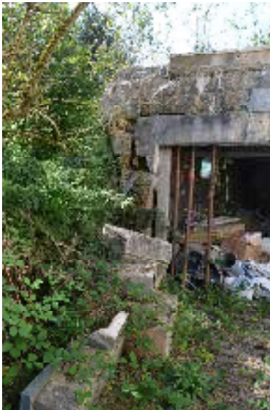
Sturz der Garage mit Stempel abgestützt
