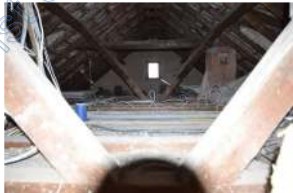
Speicher – oberste Geschossdecke nicht gedämmt
