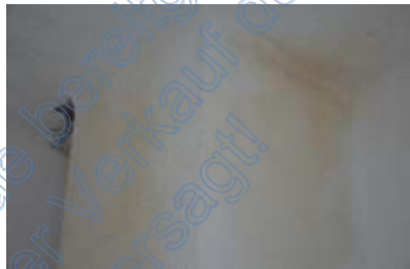
Feuchtigkeitsschäden im Dachgeschoss
