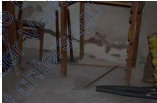
Putz- und Feuchtigkeitsschäden an Kelleraußenwand - exemplarisch
