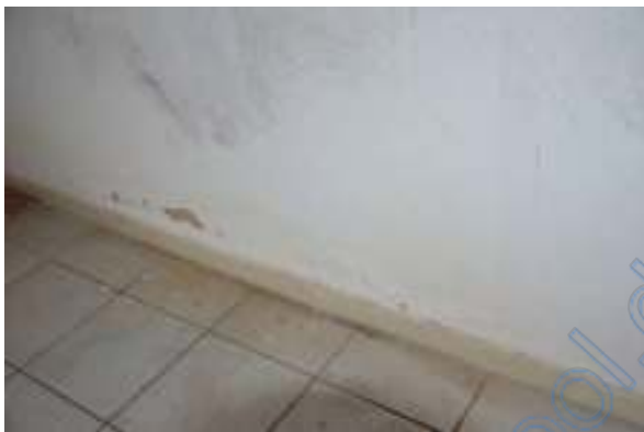
Putz- und Feuchtigkeitsschäden in UG-Wohnung - exemplarisch
