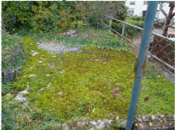
Flachdach Garage auf Parz. 142/4
