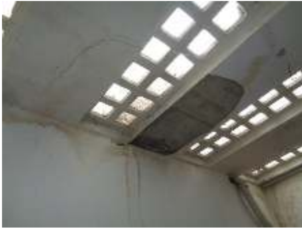
Glasbausteine in Decke zur OG-Terrasse
