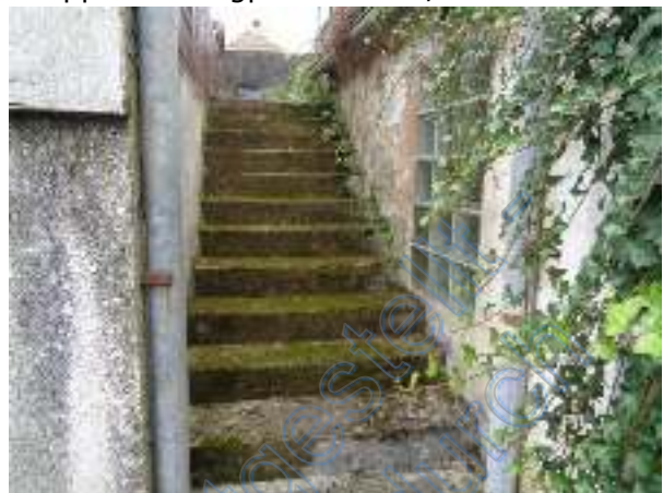
Treppe auf Wegparzelle 142/2
