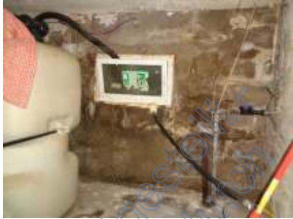
Beispiel Wand-Feuchteschäden
