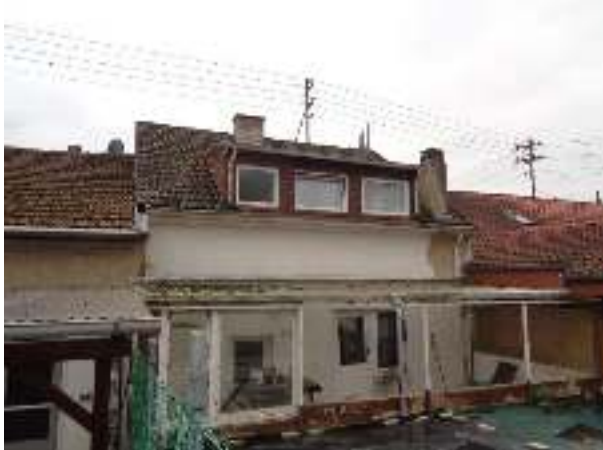
Rückansicht mit beidseitiger Anbausituation
