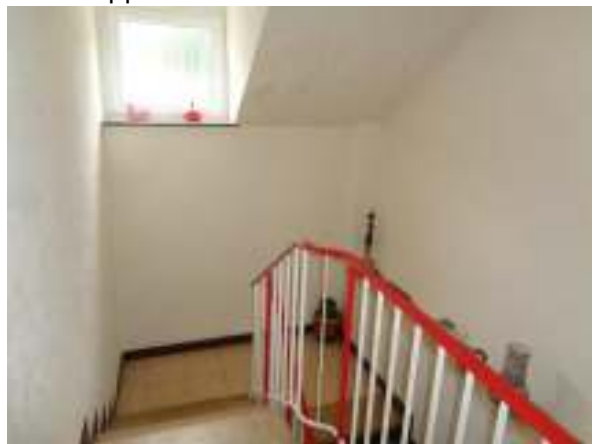
DG-Treppenhaus mit Gaubenfenster
