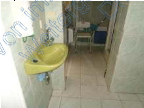
Bad; vorderer Bereich
