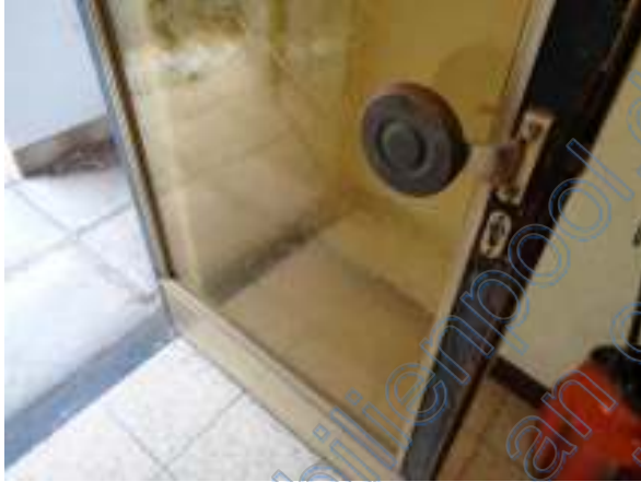
alte Metall-Haustür mit Einfach-Verglasung
