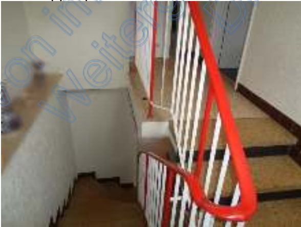
DG-Treppenpodest und Flurbereich
