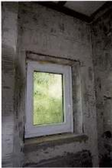
zweifachverglastes Fenster exemplarisch
