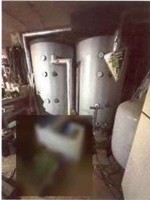
Viessmann-Öl-Heizkessel
