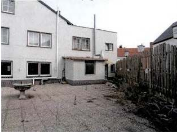
Östlicher Anbau Hauptgebäude
