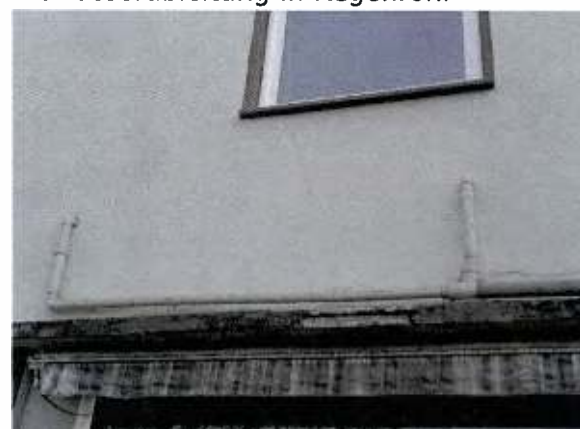
Abwasserableitung in Regenrohr
