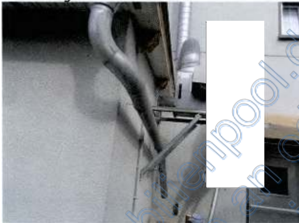
Detail Regenrohr ohne Fallrohranschluss
