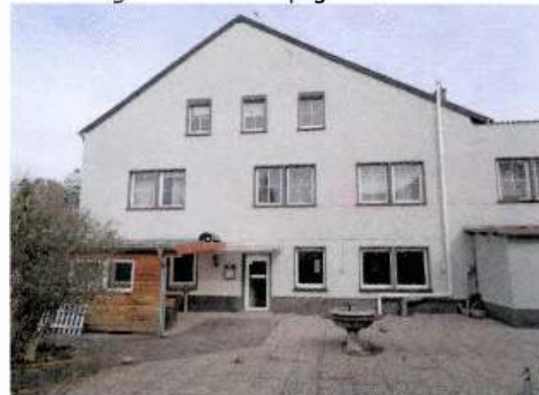
südseitiger Giebel Hauptgebäude
