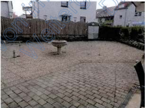
Bodenbelag Waschbeton und Verbundstein
