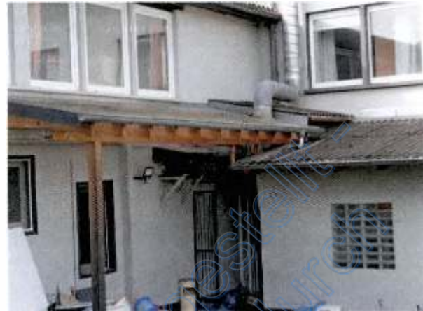
Vordach Bereich Innenhof-Außentür
