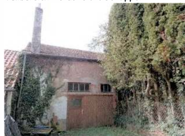
Teilbereich Nordansicht Schuppen
