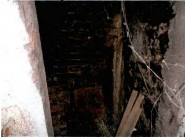
Detail ehemalige Räucherkammer im OG
