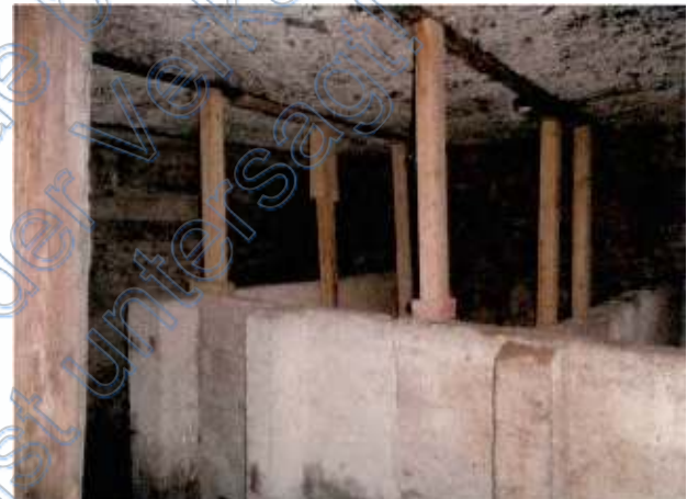
Öllageraum (nicht begehbar); Pflanzeneinwuchs ehemaliger Stall mit Notabstützungen
