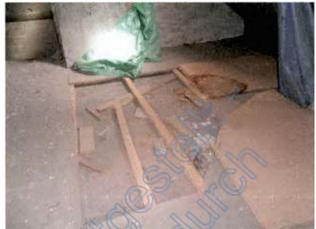
starke Verunreinigung durch Tauben u. Marder Detail fehlender Speicher-Bodenbelag
