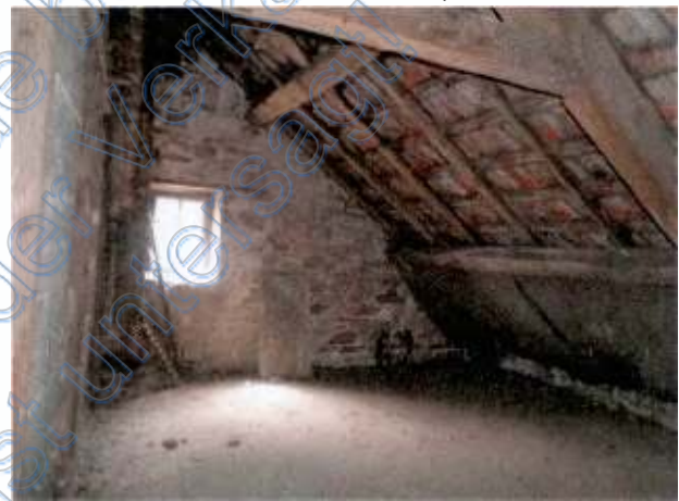
Detail Bruchsteinmauerwerk; Giebelfenster
