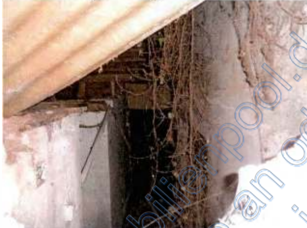
Öllageraum (nicht begehbar); Pflanzeneinwuchs ehemaliger Stall mit Notabstützungen
