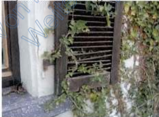
Beispiel schadhafte Holzklappäden
