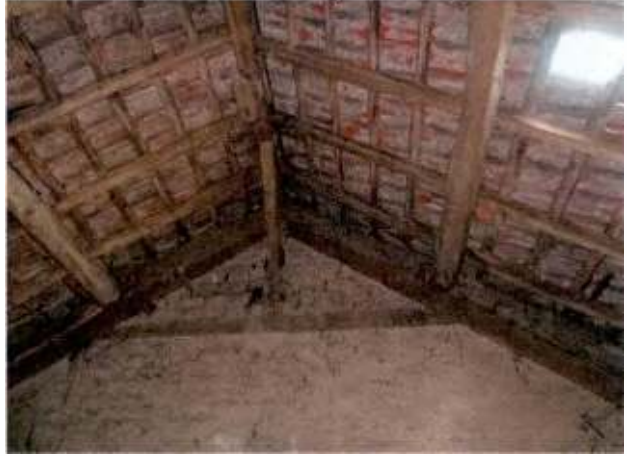
Dachuntersicht ehemaliger Heuspeicher
