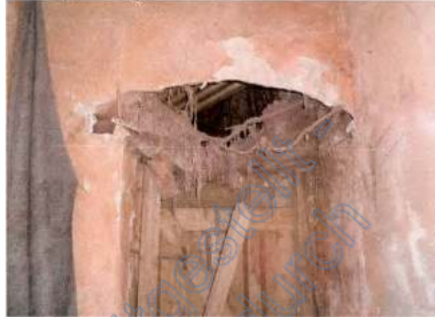
Detail langjährige Wasserschäden an Flurdecke Beispiel eingebrochener Türsturz
