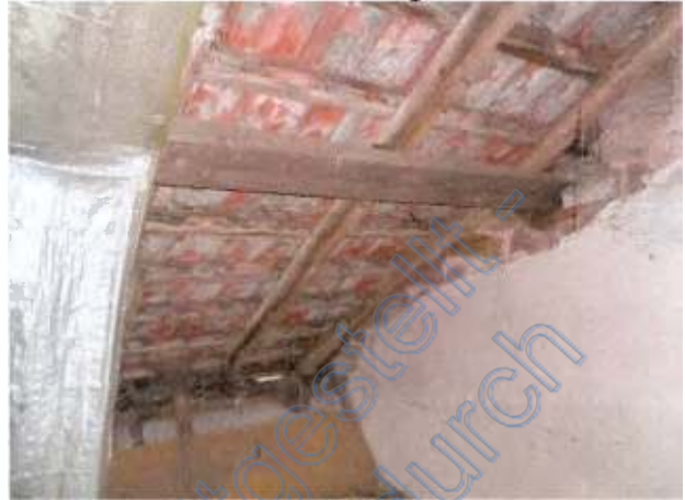
Untersicht alte Tondachziegel
