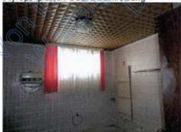
Styroporplatten-Deckenverkleidung
