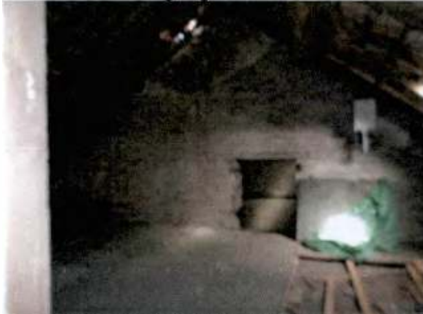
starke Verunreinigung durch Tauben u. Marder Detail fehlender Speicher-Bodenbelag
