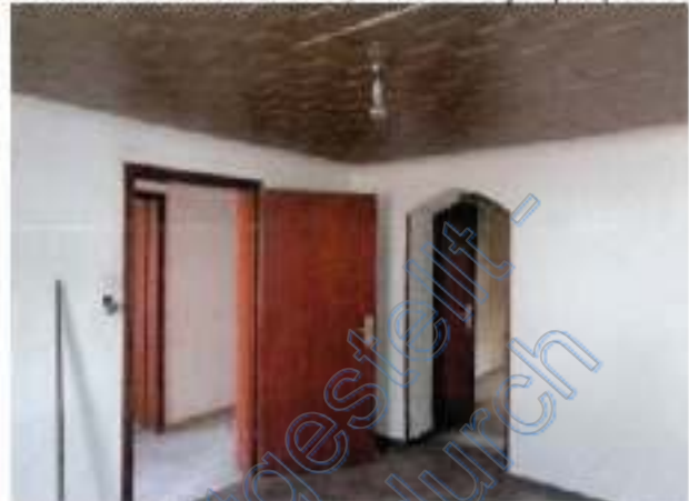
Esszimmer Vorderseite: Decke Styroporplatten
