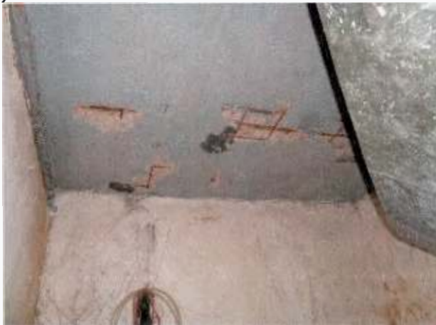
Bewuchs-Spuren (event. Efeu, Pilz, Schwamm) Korrosionsschäden an Stahlbetondecken
