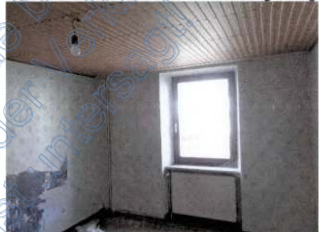
alte Holzfenster mit dünner Isolierverglasung
