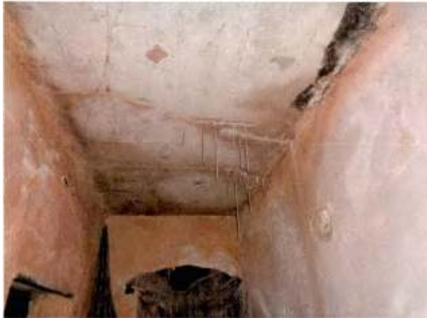
Detail langjährige Wasserschäden an Flurdecke Beispiel eingebrochener Türsturz
