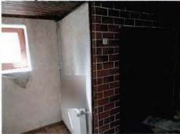
Ehemalige Ofennische im Küchenbereich
