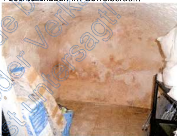
Feuchteschäden im Gewölberaum
