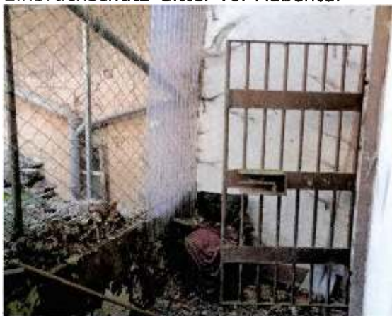
Einbruchschutz-Gitter vor Außentür
