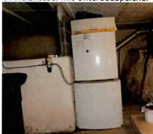
Öl-Heizkessel mit Unterbauspeicher
