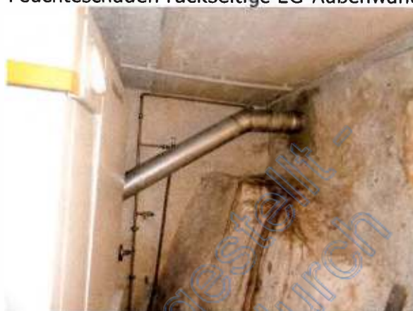
Feuchteschäden rückseitige EG-Außenwand
