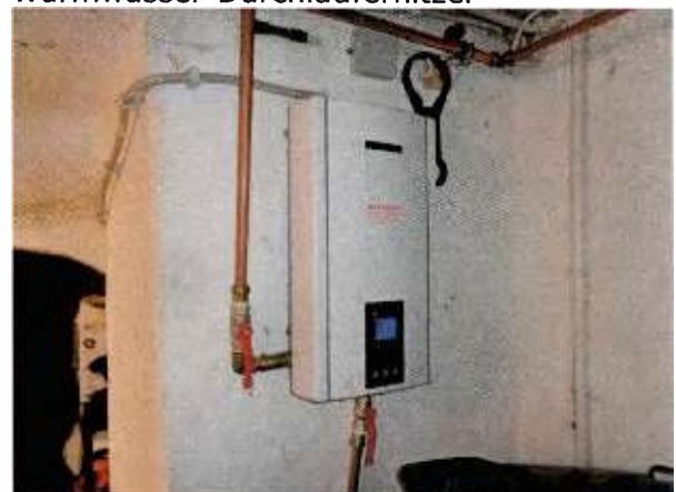
Warmwasser-Durchlauferhitzer
