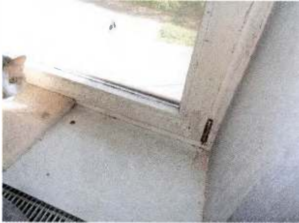
Detail Schimmel im Fensterbereich
