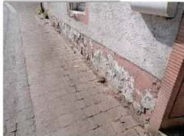
Feuchte- u. Tausalzschäden Sockelbereich
