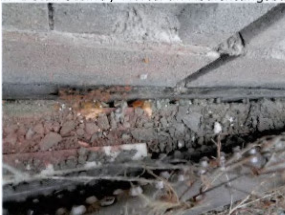
Fehlende obere Befestigung Abdichtungsbahn Detail Steine / Mörtel an Abdichtungsbahn
