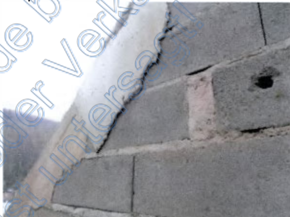
Beispiel Betonüberstände
