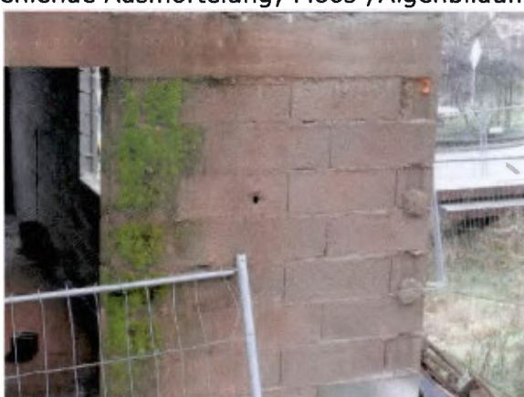
Beispiel Unebenheiten / Mörtelüberstände fehlende Ausmörtelung; Moos-/Algenbildung
