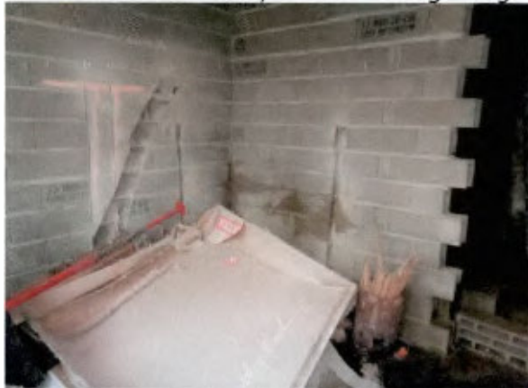
Fehlende Trennwand; Baumüllablagerungen schräger Schlitz in dünner Haustrennwand
