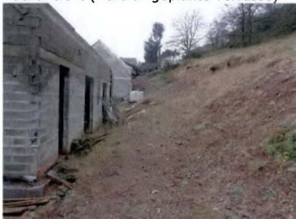
Rückansicht (Bereich geplante Terrasse)
