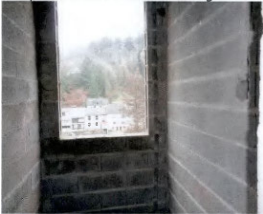
Beispiel Wandschlitz im Auflagerbereich
