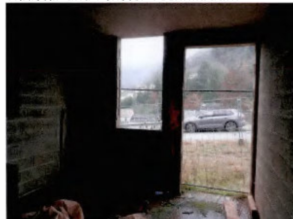
Haustür und Fenster Technikraum
