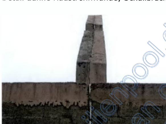
Detail dünne Haustrennwände; Schallbrücken keine durchgehende Haustrennfuge
