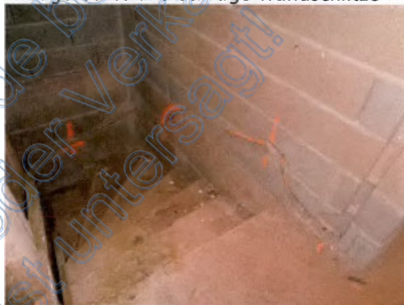
waagerechte und schräge Wandschlitz
