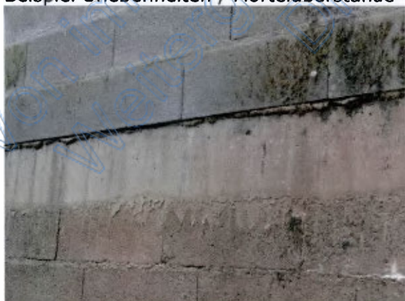
Beispiel Unebenheiten / Mörtelüberstände fehlende Ausmörtelung; Moos-/Algenbildung
