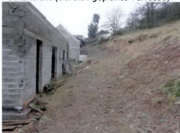
Rückansicht (Bereich geplante Terrasse)
