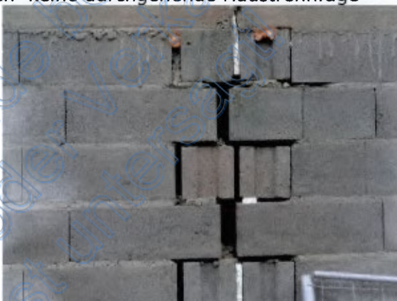
Detail dünne Haustrennwände; Schallbrücken keine durchgehende Haustrennfuge
