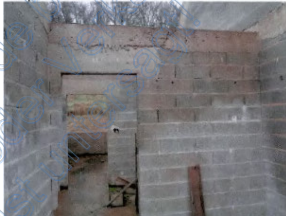
Beispiel Betonüberstände
