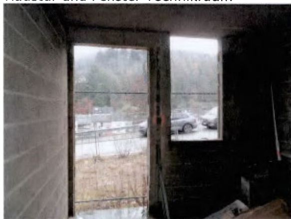
Haustür und Fenster Technikraum
