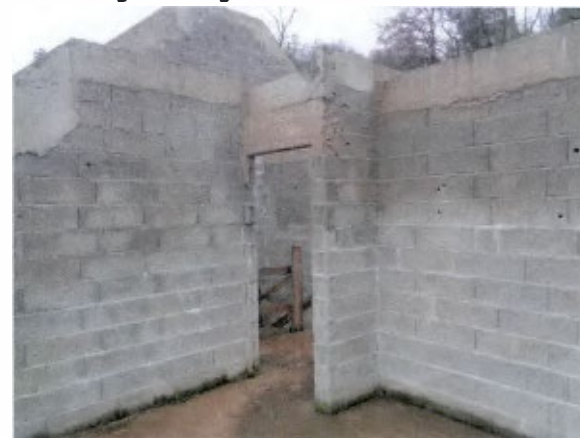
nachträglich abgestemmt Betonbauteile
