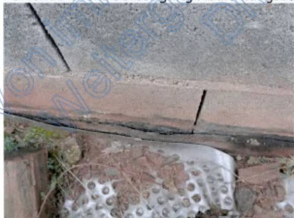
Fehlende obere Befestigung Abdichtungsbahn Detail Steine / Mörtel an Abdichtungsbahn
