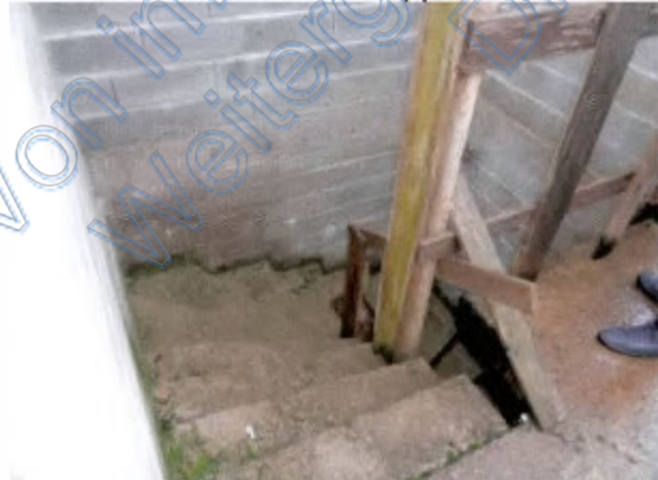
Gewendelte Stahlbetontreppe DG / EG
