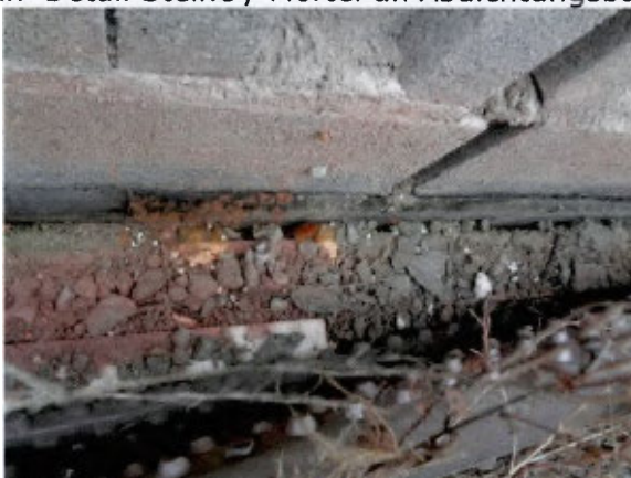
Detail Steine / Mörtel an Abdichtungsbahn
