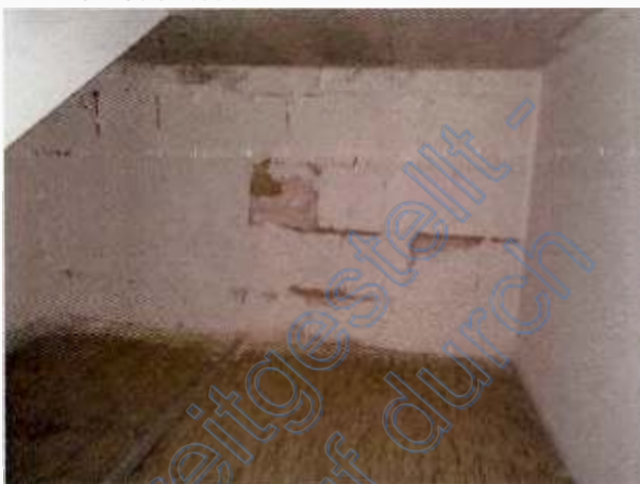
lokale Feuchteschäden KG-Außenwände
