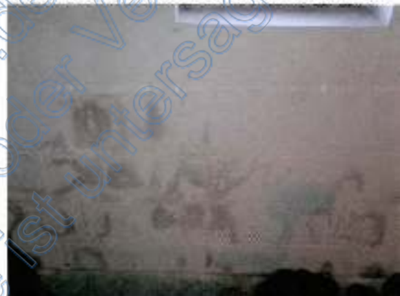
stellenweise Feuchteschäden Außenwände
