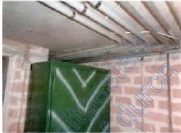
lokal fehlende Brandschutzabschlüsse
