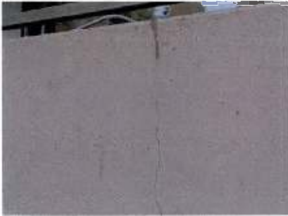
Beispiel Riss Beton-Balkonbrüstung
