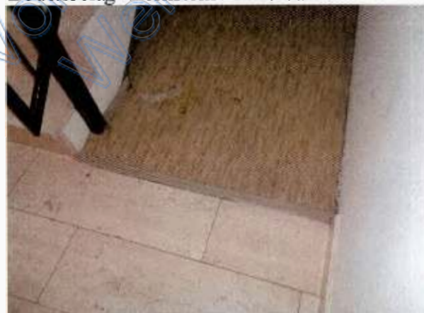
Bodenbelag Werkstein / Linoleum
