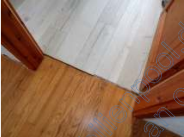
Beispiel fehlende Übergangleiste Bodenbelag
