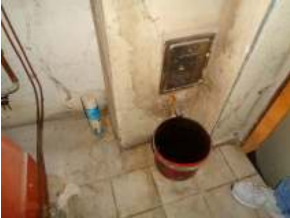
provisorische Kondensat-Ableitung
