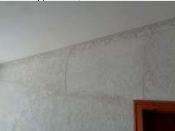
Risse Treppenhaus / Zimmer Vorderseite
