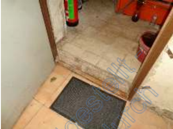
Detail Stolperstufe KG-Flur / Heizraum
