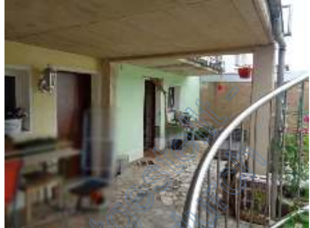
KG-Terrasse mit EG-Balkonuntersicht
