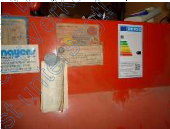
Ölheizkessel (Effizienzklasse „C“)
