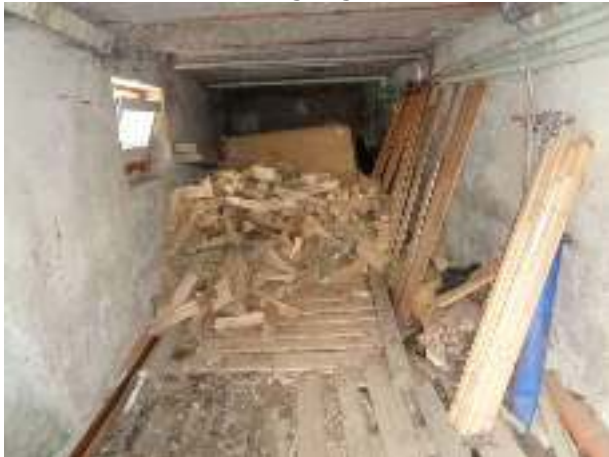
Kriechraum unter Eingangsanbau
