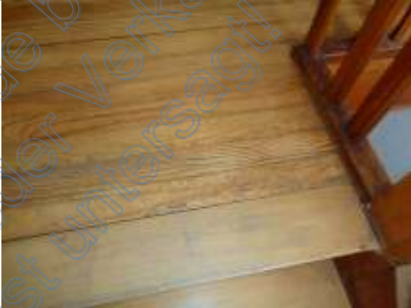
Beispiel alte Holzwurmschäden
