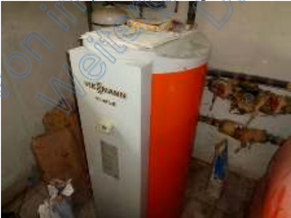
Warmwasserspeicher Ölheizung
