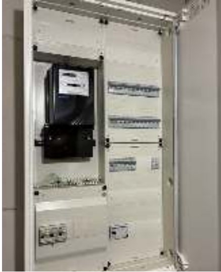
Bild 17: Elektrozahlerschrank
