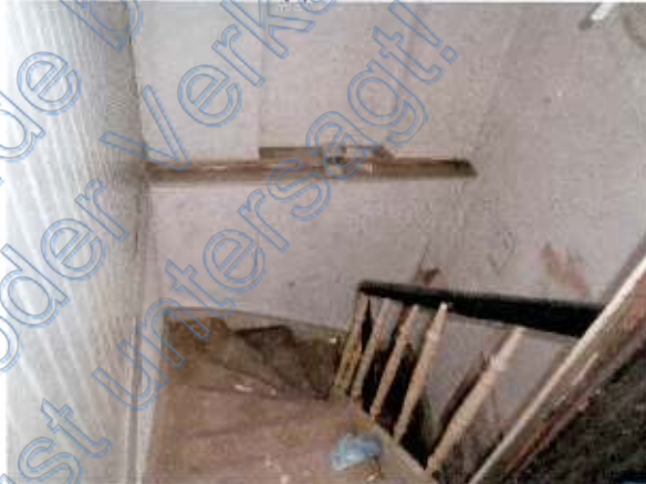
schadhafte Holztreppe im Altbauteil
