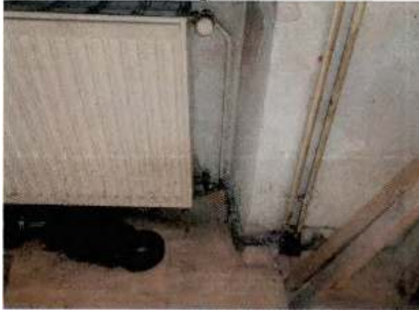
Teils über Putz verlegte Installationen
