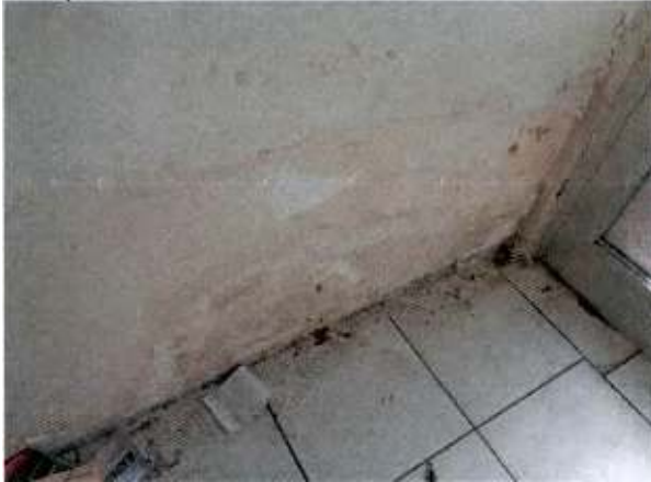
Beispiel Feuchteschäden EG-Wände
