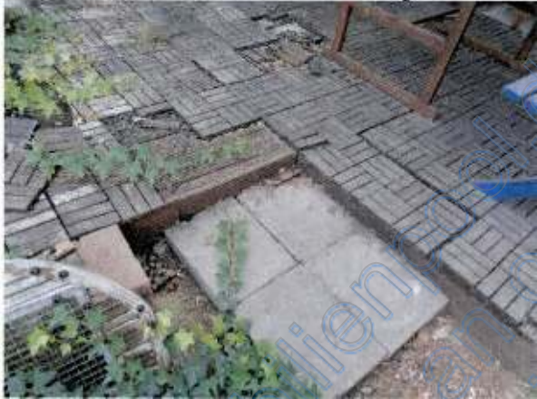
Sanierungsbedarf Terrassenbelag
