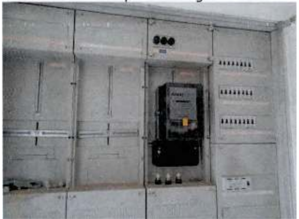
Detail Elektro-Hauptverteilung von 1982
