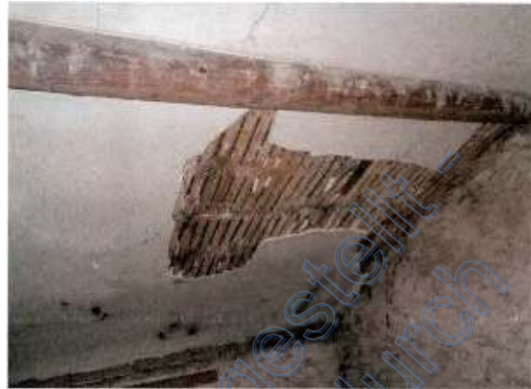
schadhafte Dachschrägen-Verkleidungen
