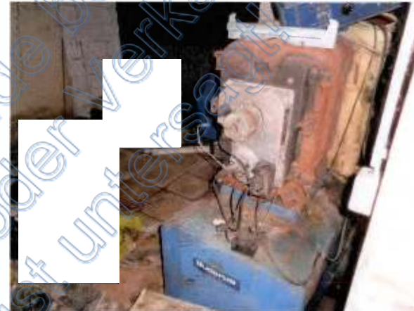
Kappendecke mit korrodierten Stahlträgern schadhafter Ölheizkessel
