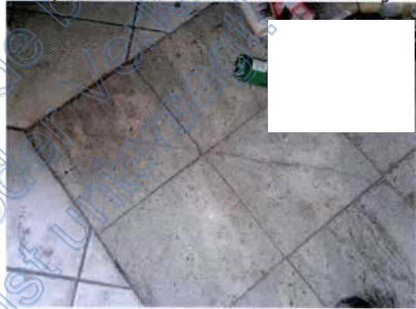
Beispiel für Riss-Schäden im Bodenbelag
