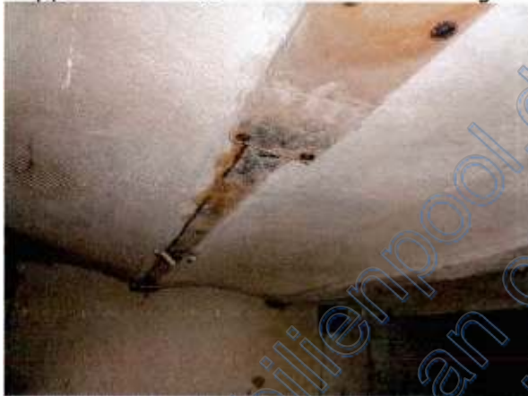
Kappendecke mit korrodierten Stahlträgern schadhafter Ölheizkessel
