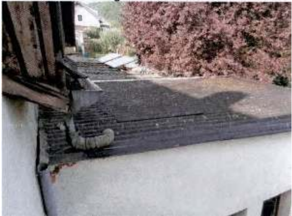
Welleternitdeckung Scheunenanbau Rückseite
