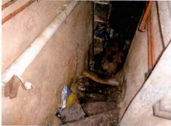
enge Treppe; ausgetretene, schmale Stufen Kellerraum Altbauteil
