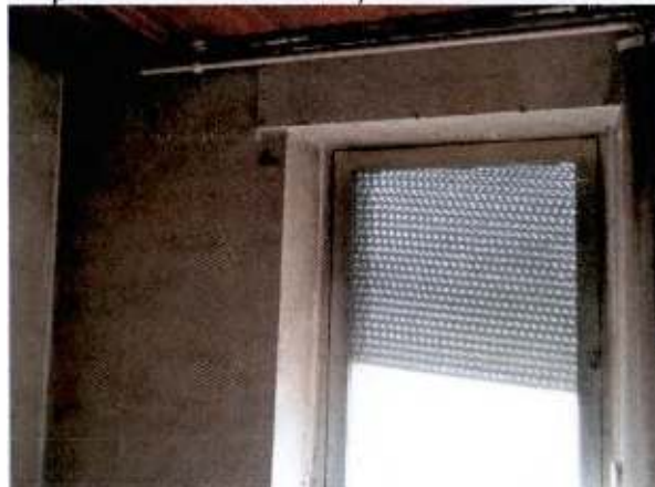
Beispiel verrußte Bauteile; schadhafter Rollladen
