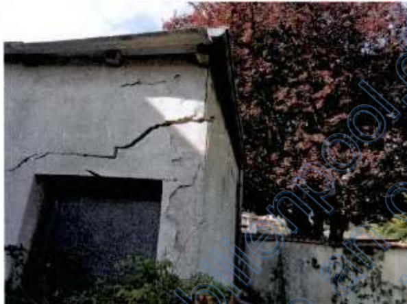
erhebliche Setzungsschäden am Anbau
