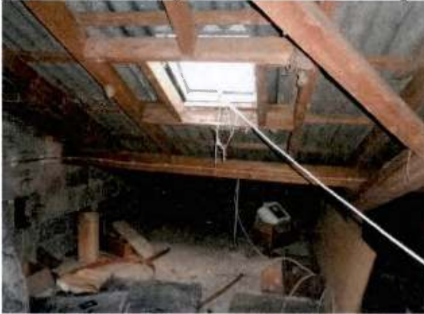
Welleternitdeckung vermutlich asbesthaltig
