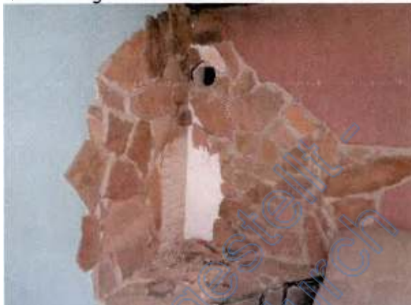
Sanierungsbedarf Kaminecke
