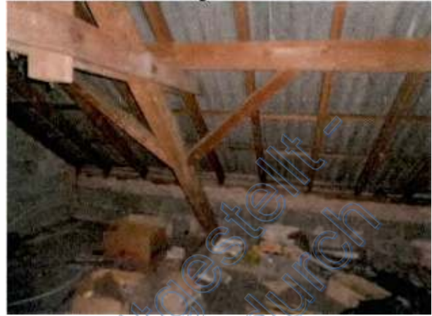
keine Dachdämmung vorhanden
