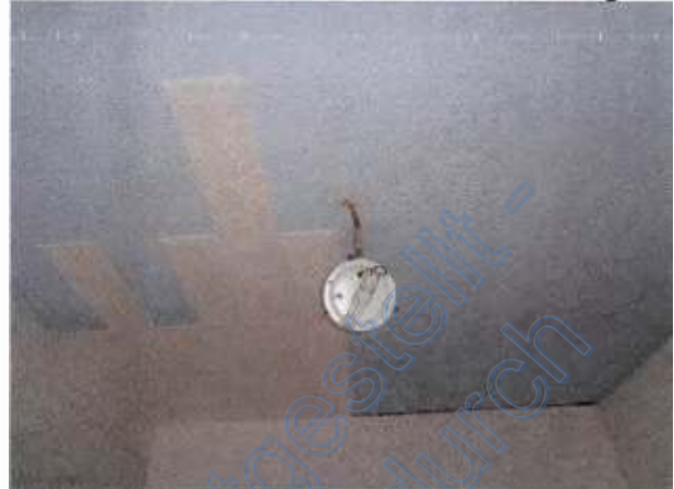
schadhafte / fehlende Deckenverkleidung
