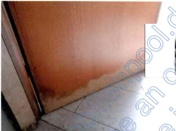
Detail Feuchteschäden an Kellertür
