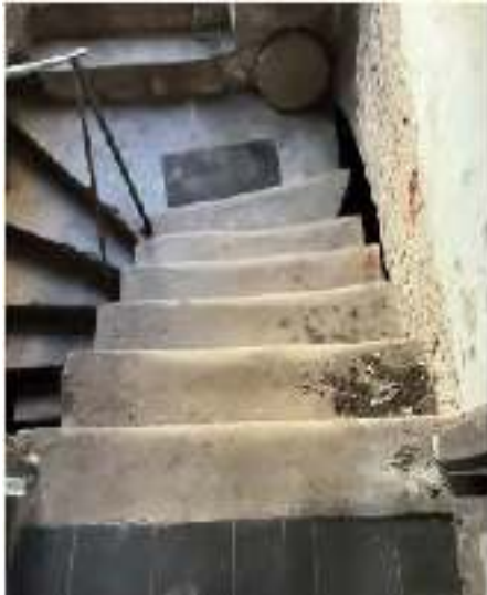
Bild 25: Treppe zum Gewölbekeller
