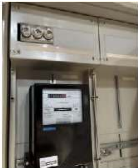
Bild 9: Elektrozahlerschrank
