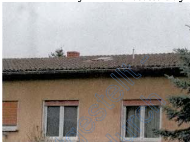
Welleternitdeckung vermutlich asbesthaltig
