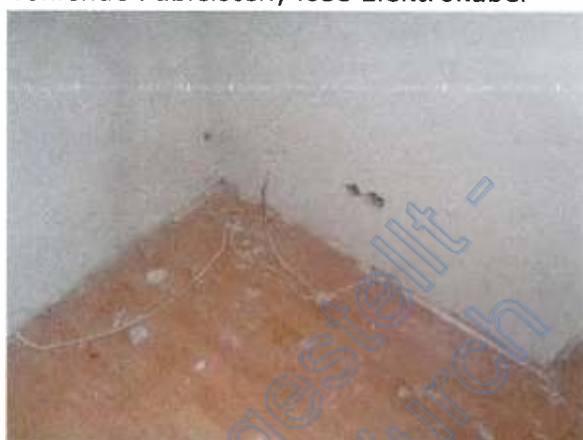
fehlende Fußleisten; lose Elektrokabel
