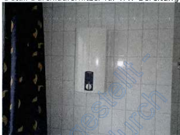
Detail Durchlauferhitzer für WW-Bereitung
