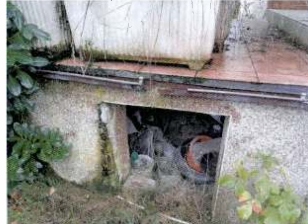
Schäden an Regenrinnen und Sockelputz
