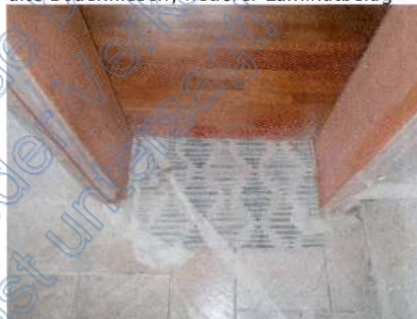
alte Bodenfliesen; neuerer Laminatbelag
