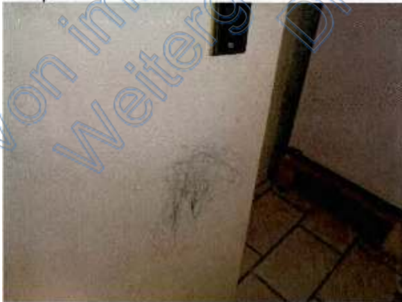
Beispiel schadhaftes Türblatt
