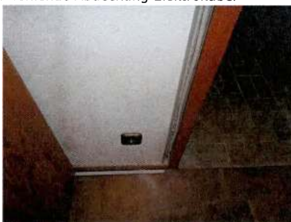
Belichtung / Belüftung nur über Wintergarten fehlende Abdeckung Elektrokabel
