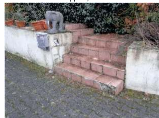
Schaden Außentreppen, fehlende Geländer
