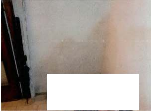
Feuchtflecken Trennwand Flur/ Dusche
