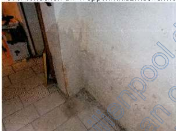
Feuchteflecken an Treppenhauszwischenwand Elektrohauptverteilung von 1989
