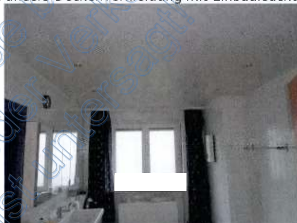
Paneele-Deckenverkleidung mit Einbauleuchten
