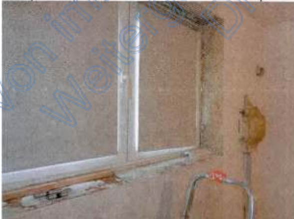
Beispiel fehlende Fensterbank und Beiputz
