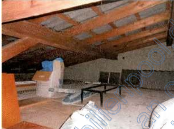
Keine Dachdämmung vorhanden
