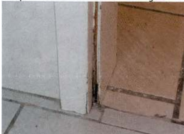
Beispiel Feuchteschäden an Türzargen
