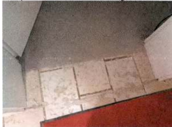
Beispiel starke Verschmutzung Fliesenbelag
