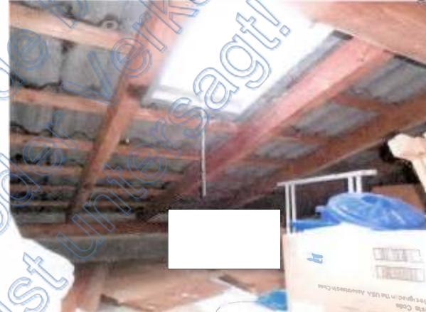
Welleternitdeckung vermutlich asbesthaltig
