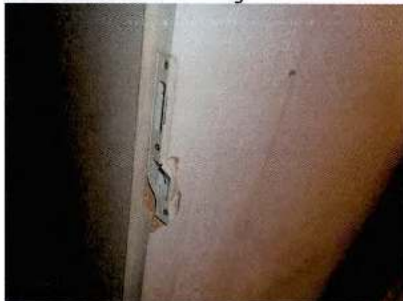
Detail schadhafte Türzarge
