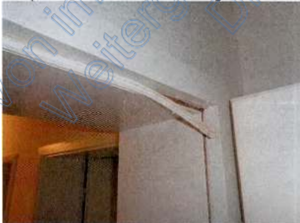
Beispiel für Schäden an Türzargen
