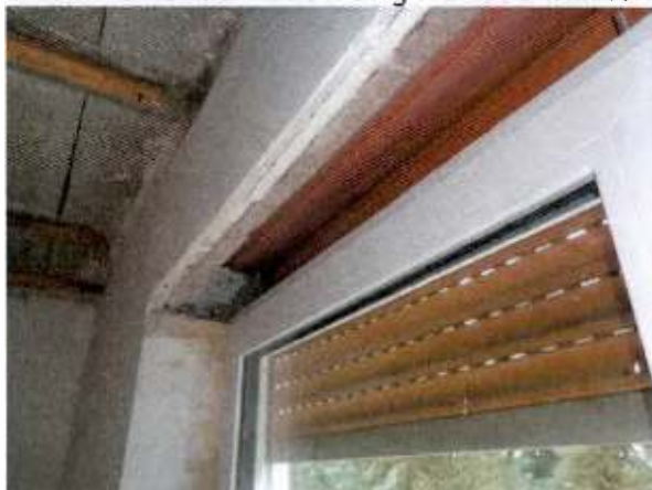
Detail fehlende Abdeckung Rollladenkasten
