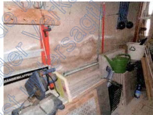
starke Feuchteschäden an Außenwand
