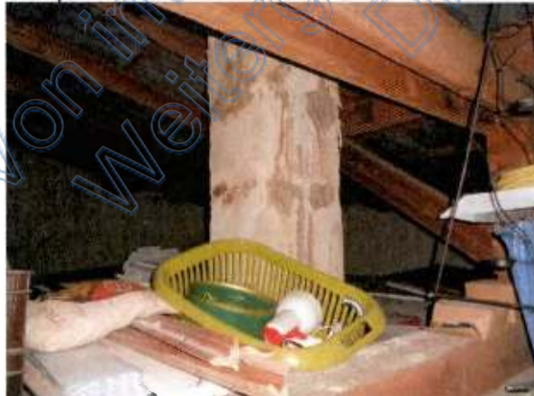
Beispiel Feuchteschäden am Kamin
