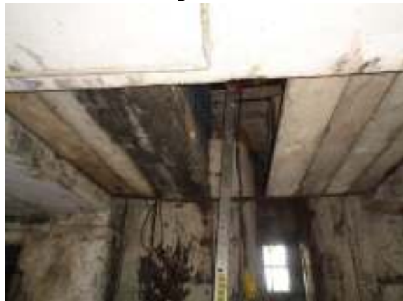
KG-Deckenöffnung zur Kelterei im EG
