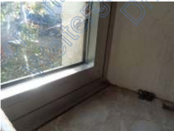
Aluminiumfenster mit Zweifachverglasung
