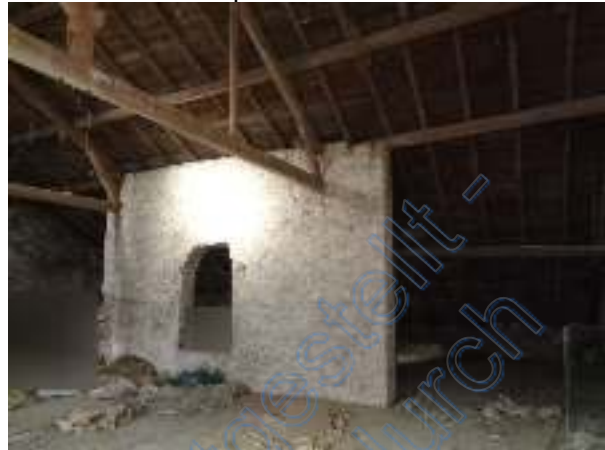
Wandstück im Speicher
