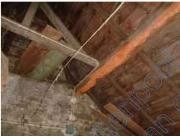
Detail altes Dachholz und Bruchsteinwände
