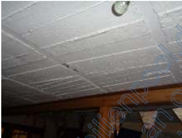
Rohe Betondecke mit Anstrich
