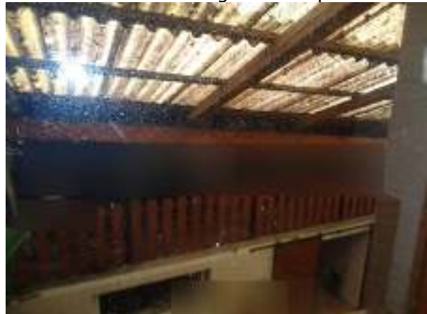
Innenhof-Überdachung mit Lichtplatten
