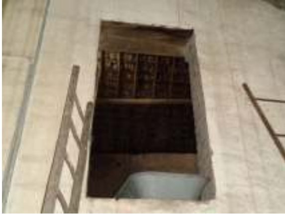
Heuspeicher über PKW-Garage „Römerstr.“
