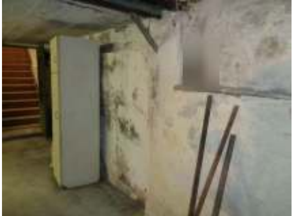
massive Treppe zur Teilunterkellerung
