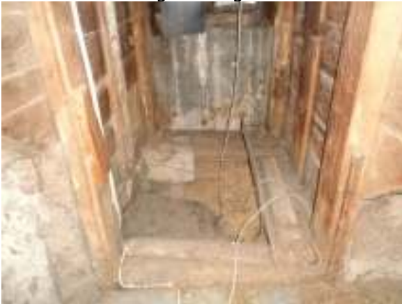
Bereich rückseitige Dachgaube
