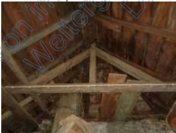
Lokale Feuchtespuren am Dachholz
