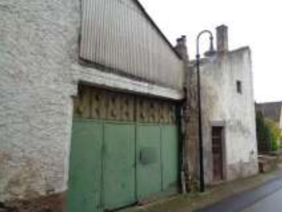
Detail Abschlusstor zur Straße „Im Hof“
