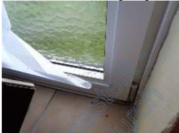
Detail Fenster mit Einfachverglasung
